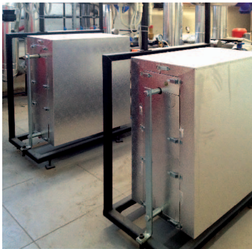
Figura 6. Un dettaglio degli scambiatori di calore. I circuiti delle utenze sono stati tutti dotati di contabilizzatori di energia termica
