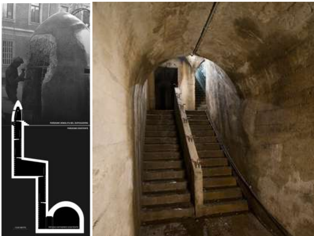
Rifugio antiaereo, scoperto durante i lavori di riqualificazione realizzati tra il 2000 e il 2003 presso i Quartieri Militari. Nell'immagine a sinistra è evidenziata la parte esistente e quella demolita (corrispondente alla zona superiore, come riportato nella fotografia). Nell'immagine a destra: il rifugio antiaereo all'epoca del ritrovamento, prima dei restauri. http://www.museodiffusotorino.it
