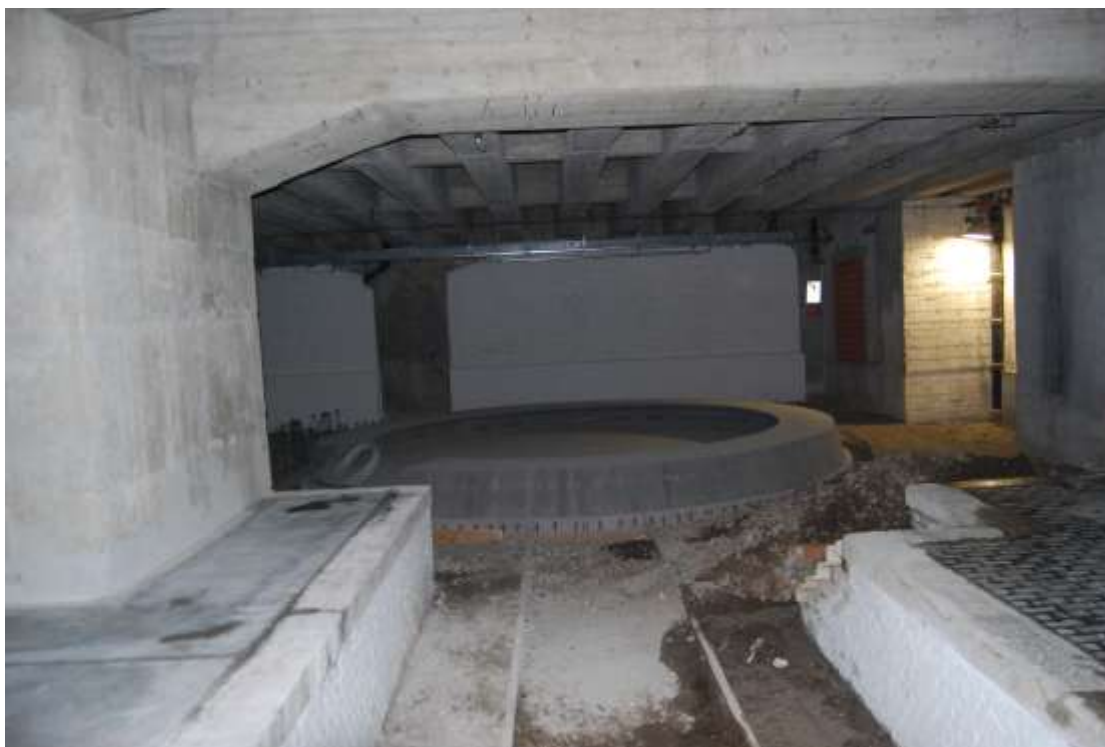
Area di cantiere nei pressi della banchina, destinata a luogo di riflessione. MVG, dicembre 2011.
