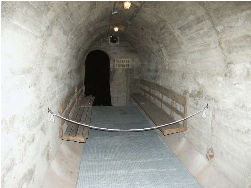
Studio Rolle e Archistudio Progetta, Rifugio antiaereo, dopo i lavori di restauro dei Quartieri militari. http://www.museodiffusotorino.it
