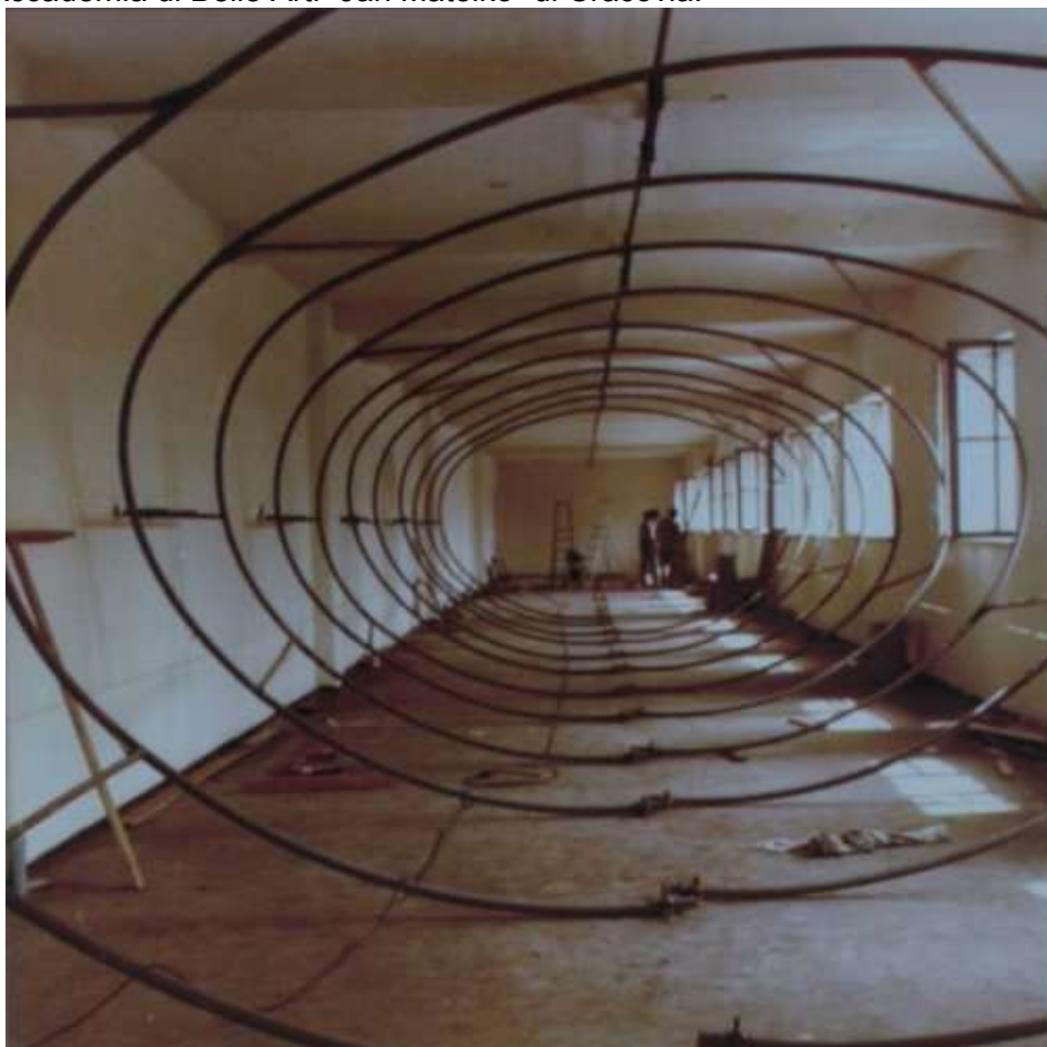
Lavori di cantiere del memoriale italiano ad Auschwitz, nel 1979. http://www.pupinosamona.it
