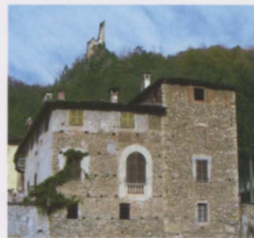
▲ Particolare del complesso addossato alla casaforte
