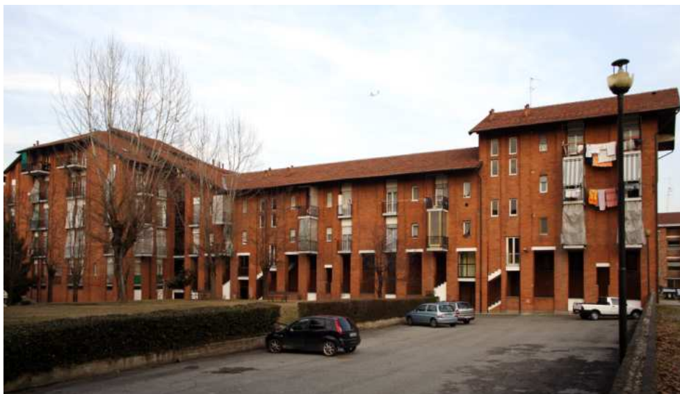
Figura 57 Fronte interno su giardino della manica. Riconoscibile l'apertura sul piano terreno che richiama i porticati rurali
