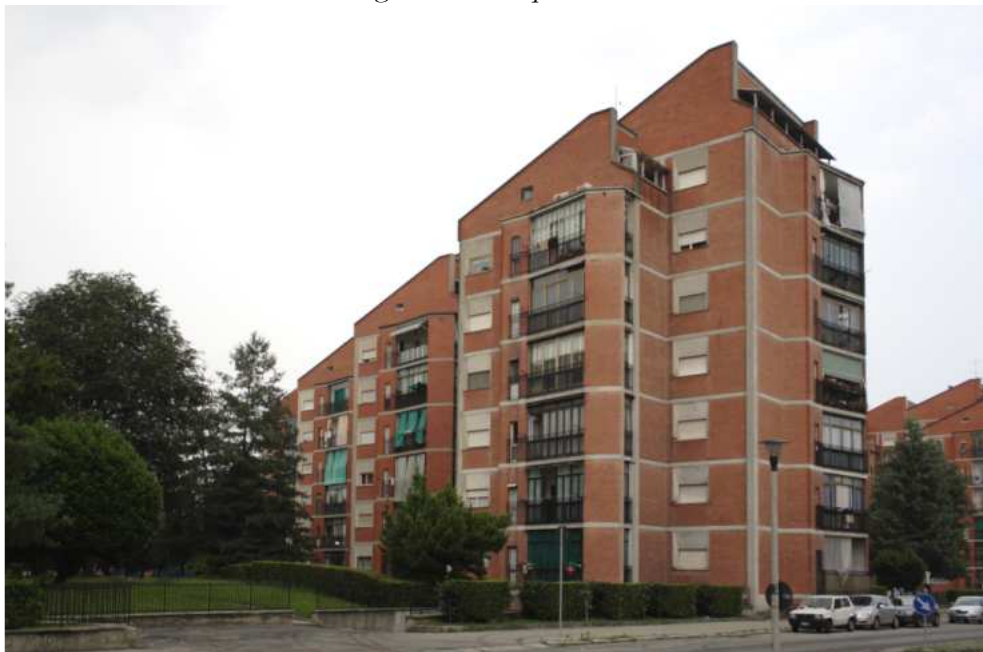
Figura 25 In determinate condizioni prospettive l'imponenza della struttura risulta mitigata dal particolare disegno del tetto
