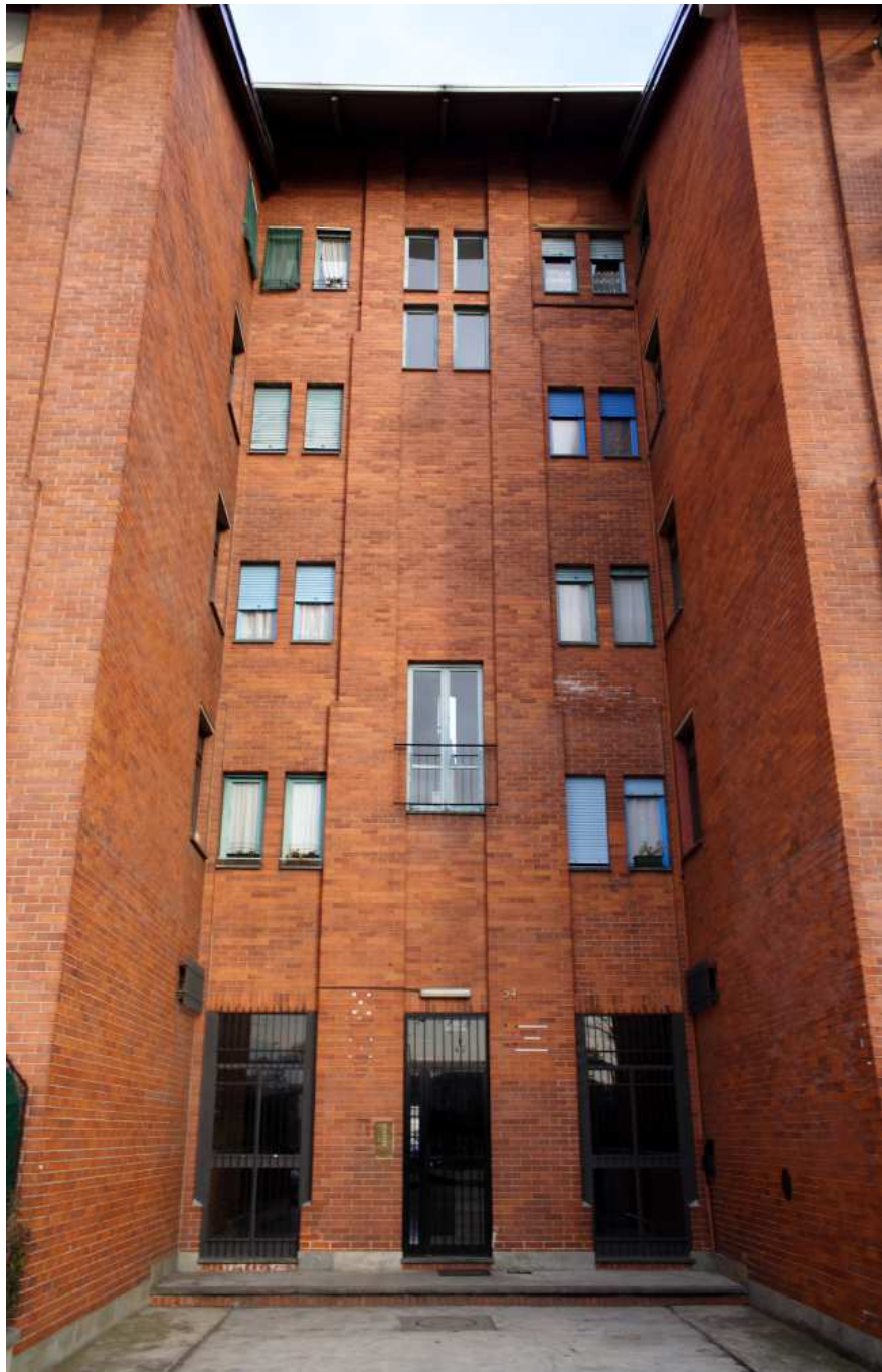
Figura 61 Ingresso di una “testata isolata”, ben riconoscibile il sistema di lesene che si rastrema verso l’alto, donando un’aria austera al complesso
