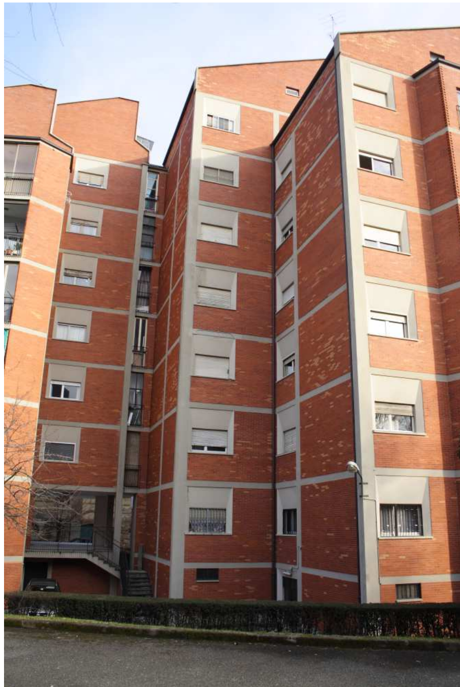
Figura 28 Fronte Ovest – Parte del corpo di ogni blocco è più basso del resto della struttura, 6 piani f.t. invece di 7
