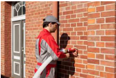
Figura 20 Intervento di insufflaggio su muratura in mattoni a vista
