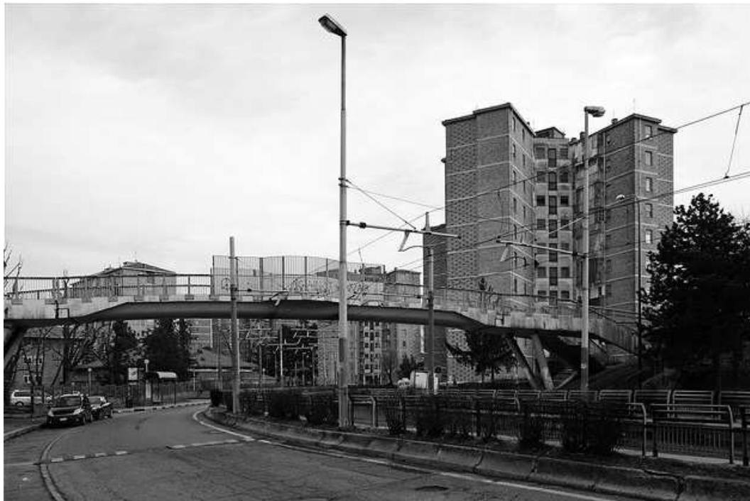
Figura 15 Sovrappasso pedonale su Viale dei Mughetti
