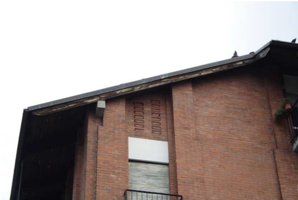
Figura 62 Particolare della copertura lignea
