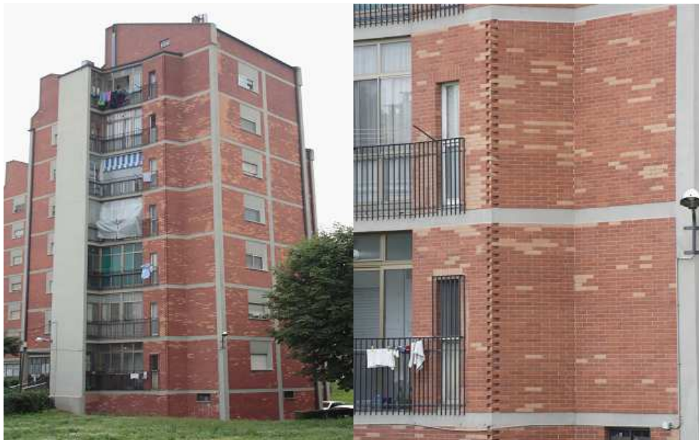
Figura 26 Testata Nord su Corso Ferrara, si nota la non uniformità dei mattoni, forse dovuto ad un intervento manutentivo della facciata. Si può notare anche la giacitura dei mattoni nell'angolo
