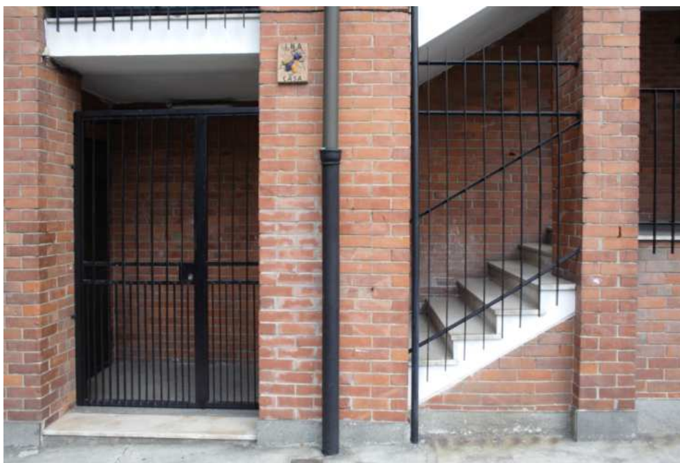
Figura 60 Particolare di uno degli ingressi sul fronte interno
