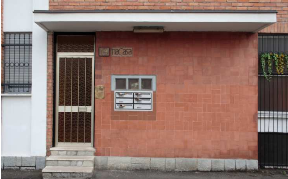
Figura 38 Ingresso fronte Nord, si nota la sostituzione del portoncino e i lavori di manutenzione che hanno interessato la pensilina e una fascia di muratura
