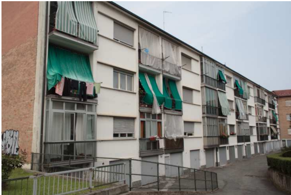
Figura 41 Fronte Sud con l'accesso ai box nel seminterrato, si possono notare le immancabili verande e la non uniformità della scelta delle tende, di varie fogge e tessuti
