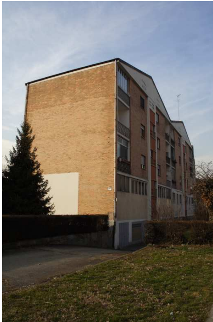
Figura 48 Testata Sud, si nota la rampa di accesso ai box e le differenti tessiture dei mattoni a vista
