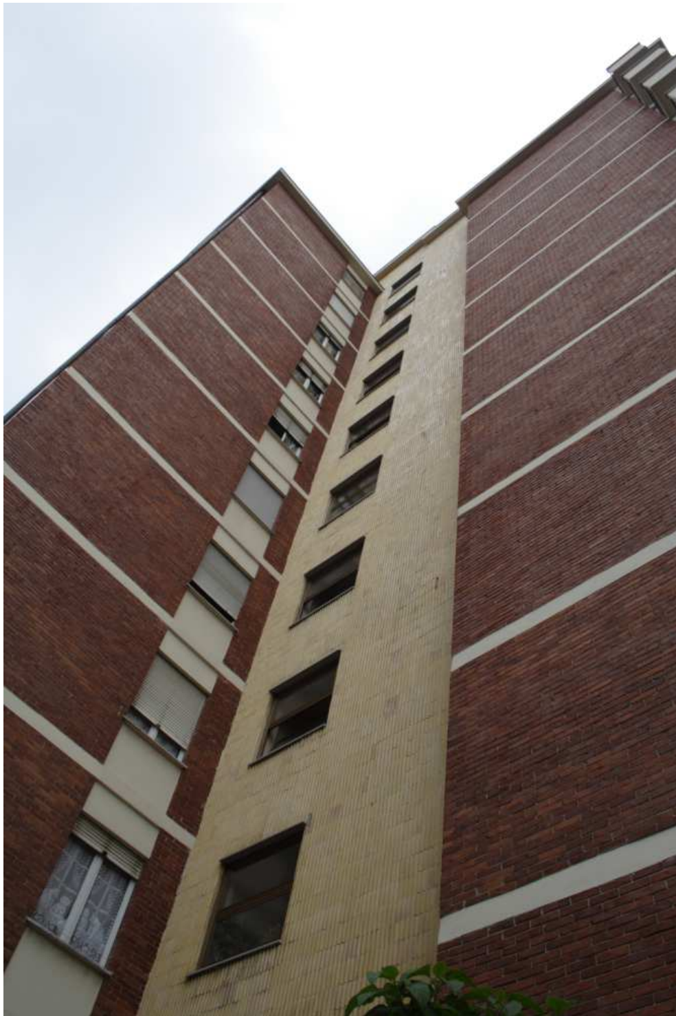
Figura 75 Particolare del rivestimento sul fronte Nord, in cui coesistono mattoni a vista, intonaco e rivestimento ceramico
