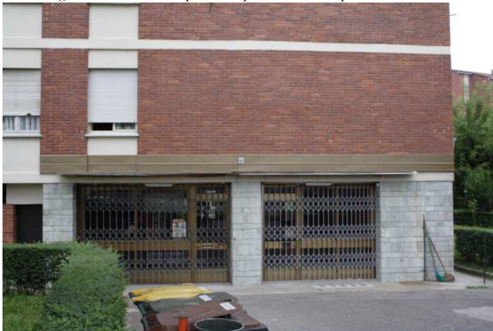
Figura 74 Particolare del piano terreno e del rivestimento del basamento
