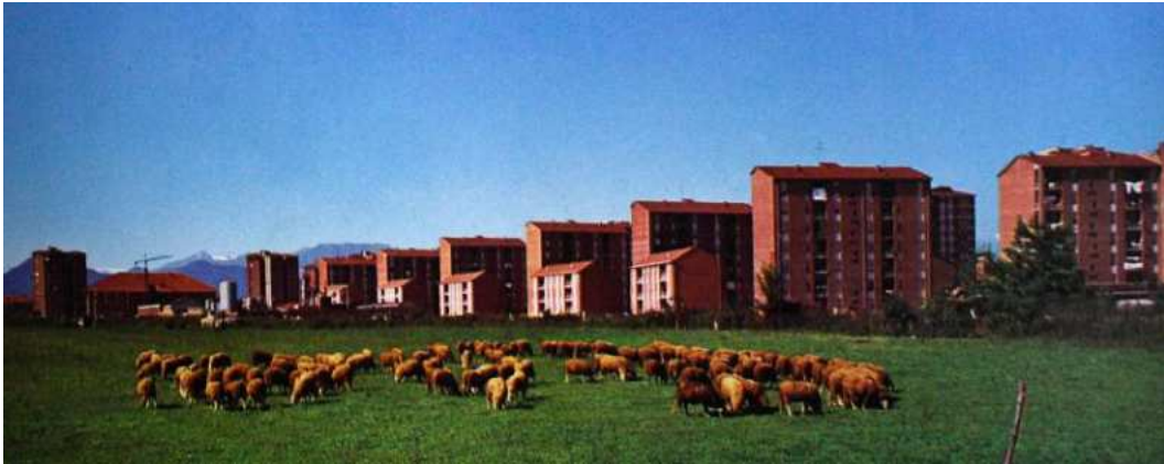
Figura 5 Gregge di pecore accanto al nuovo quartiere
