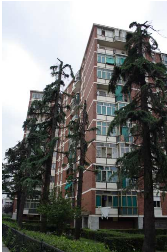
Figura 73 Fronte Sud quasi completamente tamponato da verande
