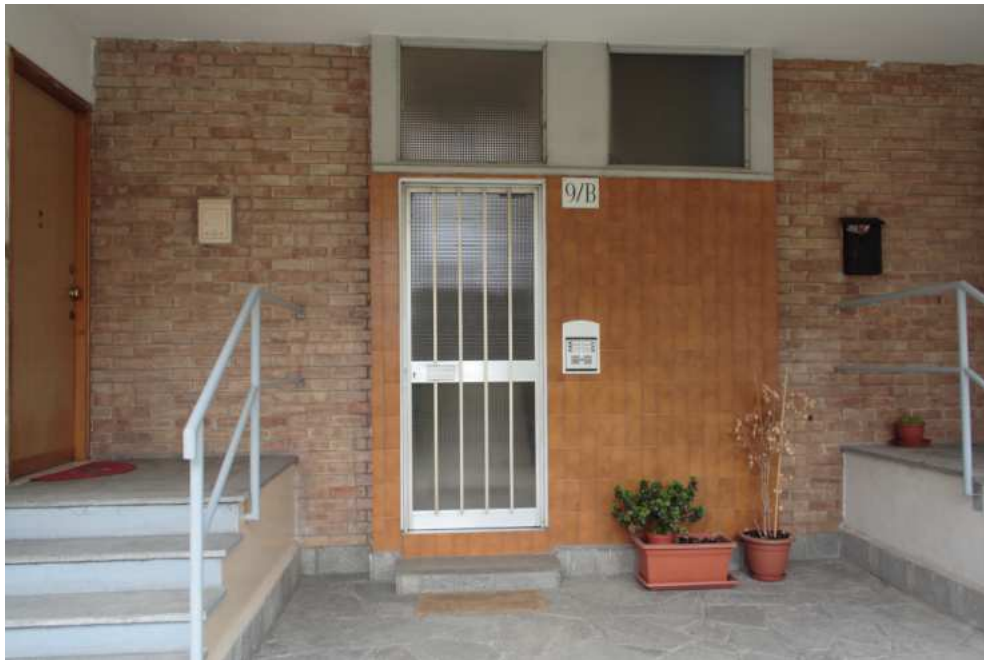
Figura 53 Ingresso sotto al porticato, si nota la sostituzione del portoncino e probabilmente anche del rivestimento attorno
