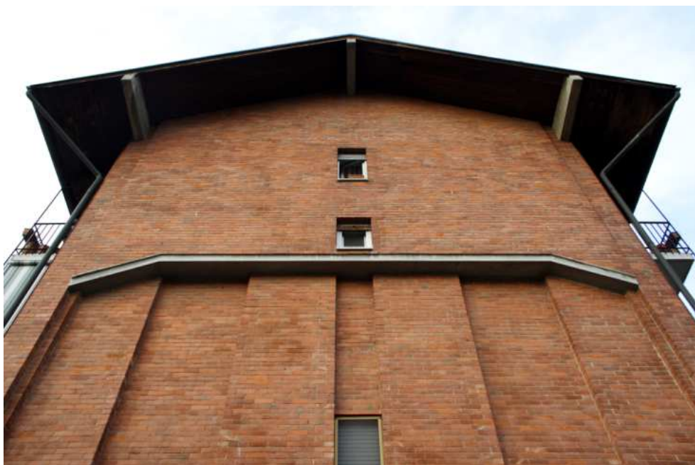
Figura 58 Particolare della testata della manica con il profilo di cemento armato che interrompe lo schema decorativo della muratura a vista
