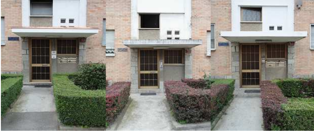
Figura 40 Ingressi fronte Ovest
