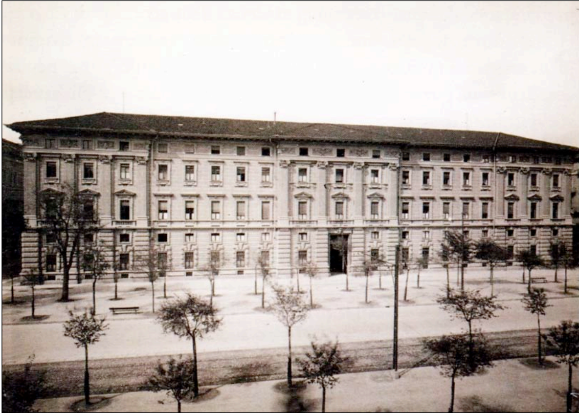
231. 1911, Carlo Angelo CERESA, Palazzo Pralormo, Circolo Ufficiali di Presidio, ex Scuola di Guerra, Torino . Veduta dall'alto del prospetto principale della Scuola di Guerra del 1930 ca. Durante la Grande Guerra la Scuola subisce diversi adattamenti alle nuove esigenze d'uso e negli anni Trenta le due maniche laterali sono ampliate: la manica destra è prolungata su via Ruffini; al piano terreno, oltre alla sala di scherma, sono realizzati un ampio salone quadrato e una saletta neo-barocca; la manica di sinistra è prolungata con bassi fabbricati che accolgono la mensa e le cucine. Nel dopoguerra la sala della scherma è trasformata in un ampio salone per le feste, oggi utilizzato per le grandi cerimonie. http://www.museotorino.it/view/s/288a03c2fb0c4c388f7074b20c608887
