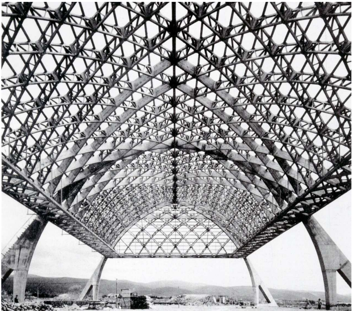
Fig. 148 – PIER LUIGI NERVI, Cantiere delle aviorimesse della seconda serie, 1939.
