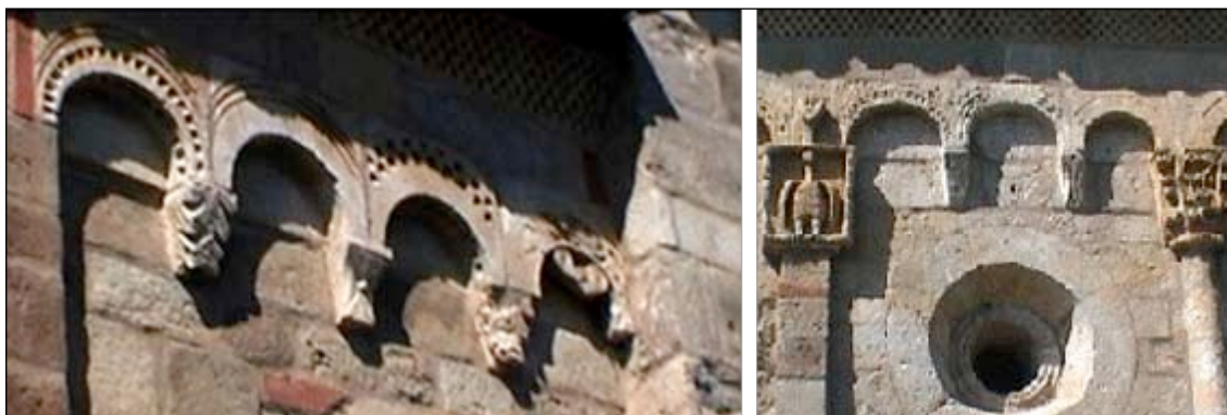
21. Archetti lato sud della chiesa di San Secondo di Cortazzone di Asti. in: http://www.cosmologia-arcaica.com/san_secondo/esterno.html
