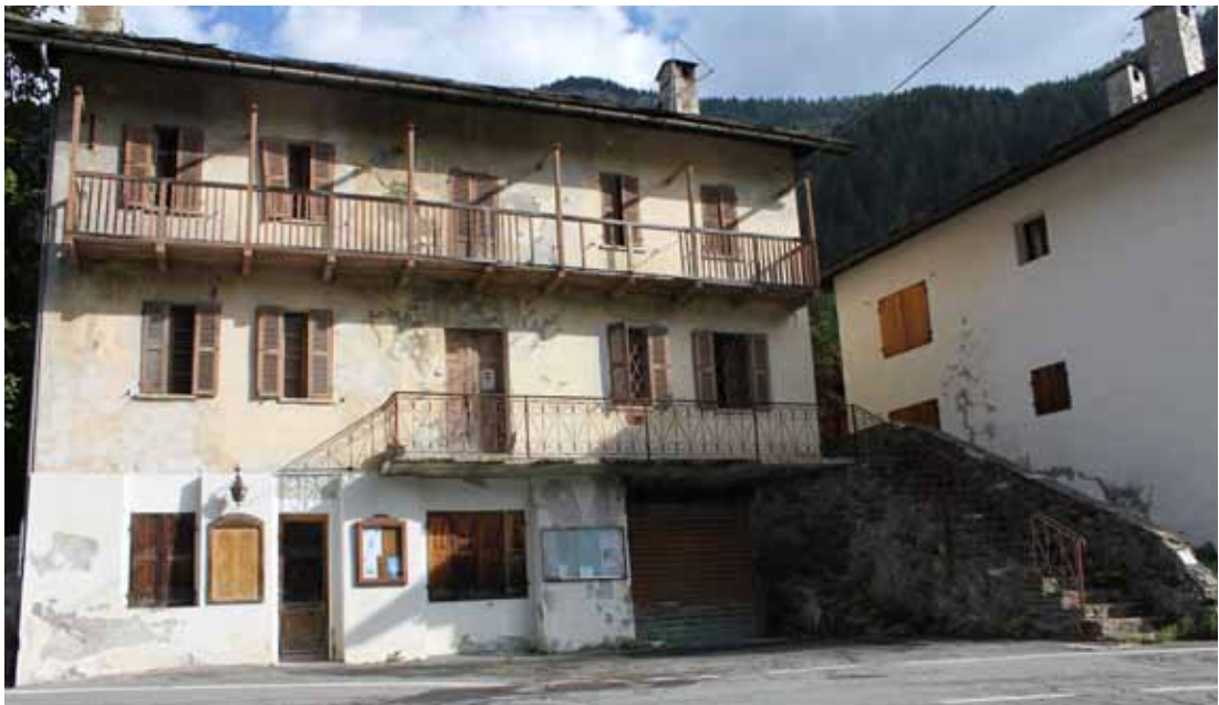
Figura 2.2.8: Il fabbricato in ristrutturazione come Centro visitatori del Parco Mont Avic
