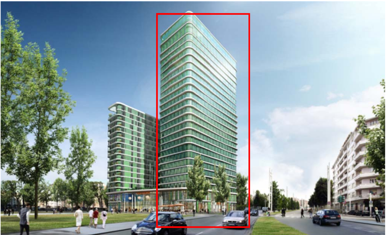
Figura 3.2.1 – Contestualizzazione del caso studio. Nel riquadro, l'edificio oggetto di simulazione.
