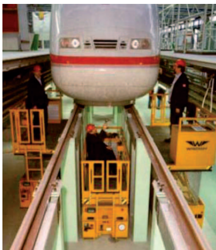
Fig. 13 - Piattaforme elettro-pneumatiche in azione tra le rotaie sopraelevate. Electro-pneumatic platforms in action between the overhead rails.
