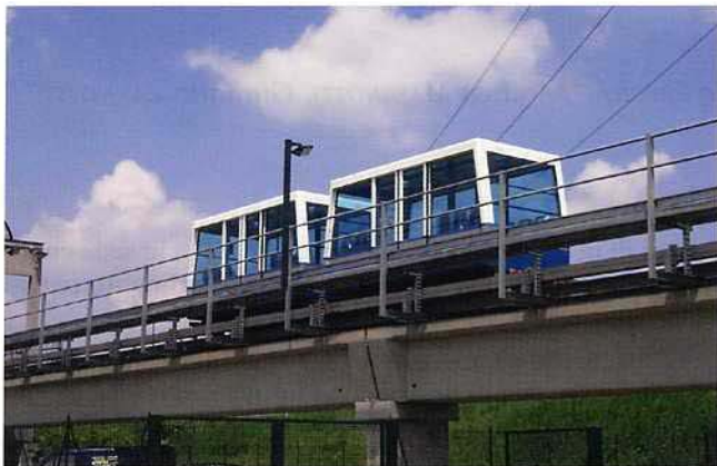
Fig. 1 – Esempio di linea in viadotto.
