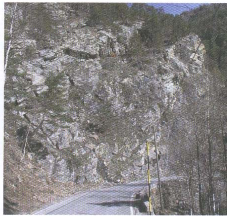
FIG. 5 - Esempio citato: tratto di strada soggetta a dissesti e stereogramma relativo. L'ammasso roccioso è marcatamente discontinuo, con presenza sia di blocchi sia di lastre. Reference example: geostructural stereonet of a rock slope subjected to rock fall. The rock mass is a discontinuum, characterized by both blocky elements and slabs.
