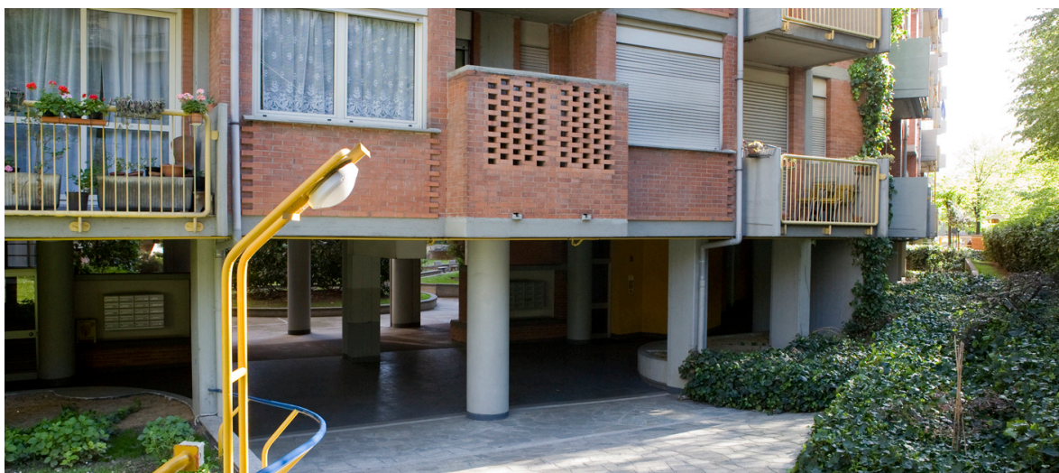
Condominio Pitagora, il piano terreno con gli accessi dalla strada. Oltre i pilotis . Fotografia di Michela Pace, 2013.
