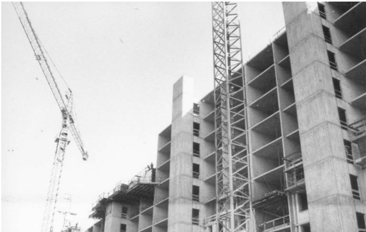
Il cantiere del consorzio edilizio Bologna, 1976. In Alsbc, Fondo Co.Ar., L 500 Bologna.
