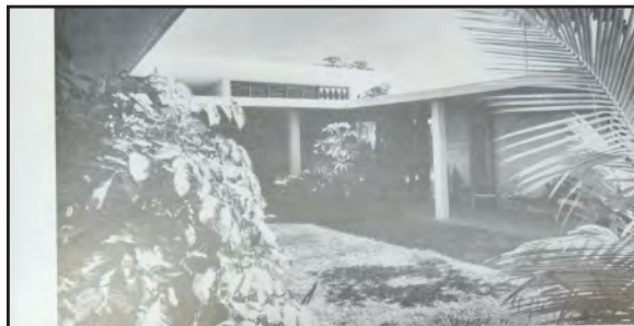
Vista del patio central con las galerías que lo rodean y las fuertes policromadas que permiten la ventilación superior en las plazas principales. Frank Martínez Justiz, Arquitecto.
