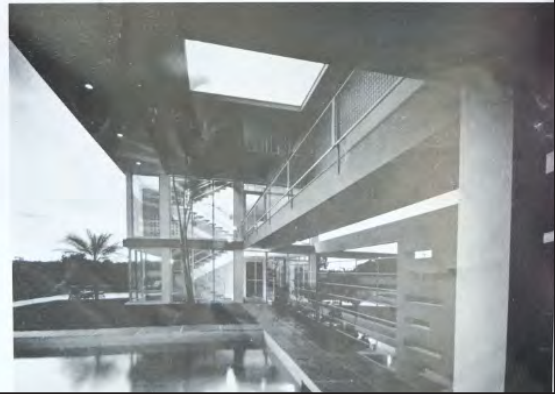
RESIDENCIA EN EL 'COUNTRY' CLUB DEL ORO DE LA NOVAL. VISTA DEL PATIO Y PISCINA. ARQUITECTOS SILVERIO BOSCH Y MARIO ROMAÑACH.
