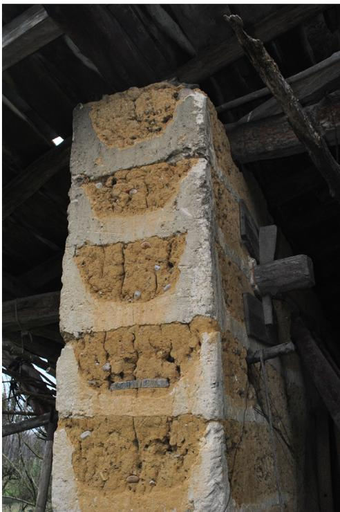
Fig. 2.17, Dombes, Rhône – Alpes, particolare rinforzo angolare con malta di calce. Il sistema ricorda quello "Calicastrado", utilizzato in Spagna, ma in quest'ultimo le pareti sono interamente rivestite a calce (Mileto, Vegas, Cristini, Garcia 2012).
