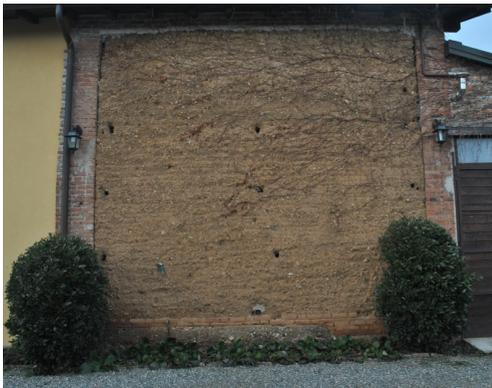
*Fig. 2.13, Novi Ligure (AL), Piemonte, il muro in terra battuta è utilizzato come riempimento collaborante di una struttura di pilastri in mattoni cotti; il sistema è particolarmente diffuso in Piemonte.*
