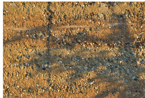
Fig. 2.1, Texture di un muro in terra battuta a Novi Ligure (AL), si nota forte presenza di uno scheletro di ciottoli.
