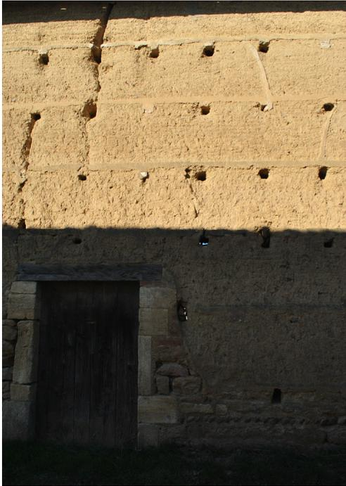
*Fig. 2.12, Dombes, Rhône – Alpes, sono visibili i filari di blocchi di cui è composto il muro in terra battuta, con giunti verticali inclinati in modo da favorire l'ammorsatura.*
