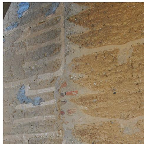
Fig. 2.15, Francia, Rhône – Alpes, due pareti contigue in pisé, realizzate con tecniche di giunzione d'angolo diverse: con inserzioni di un letto di malta di calce (sinistra) e con rinforzi sempre in malta di calce, ma in forma triangolare (destra).
