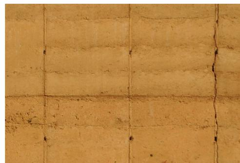
Fig. 2.3, Muro in pisé realizzato a Oaxaca, Messico; la superficie della parete appare meno ricca di ghiaia, ma, essendo la costruzione molto più recente, l'effetto potrebbe dipendere dalla minore erosione dello strato superficiale della parete ad opera degli agenti atmosferici.
