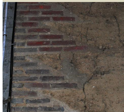
Fig. 2.16, Francia, Rhône – Alpes, tecnica di rafforzamento degli angoli che prevede l'inserimento di mattoni cotti con un profilo triangolare che riprende quello dei giunti dei blocchi di pisé, in modo da facilitare l'ammassatura con il muro in terra. Viene utilizzato su un lato della parete come elemento di partenza della sua costruzione, e dall'altro come elemento di chiusura (Bollini 2013).
