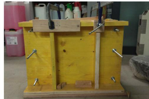
**Fig. 7.59.** Costruzione casseri: le assi principali dei casseri sono rinforzate con elementi verticali ed orizzontali per evitare spaccamenti in fase di compattazione.
