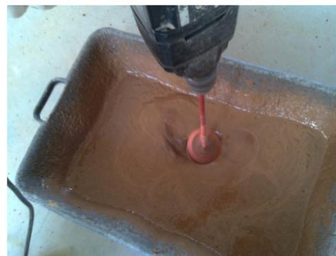
Fig. 7.74, La barbottina di terra è stata realizzata con un miscelatore in combinazione con un trapano.
