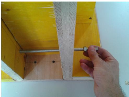
*Fig. 7.55, Costruzione casseri: Gli assi laterali sono più lunghi per permettere il fissaggio con barre filettate.*
