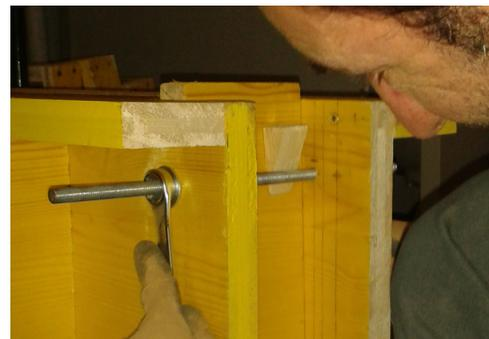
*Fig. 7.64, Realizzazione muri campione in terra battuta: i bulloni vengono allentati prima di rimuovere i cunei durante lo smontaggio dei casseri per evitare tensioni sui campioni.*
