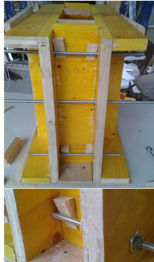
**Fig. 7.57-7.58.** Costruzione casseri: le assi di testa vengono bloccate per mezzo di cunei in legno.
