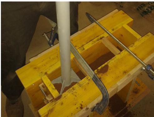
Fig. 7.62, Realizzazione muri campione in terra battuta: la terra viene compattata per strati di 10 cm con il pestello in ferro.
