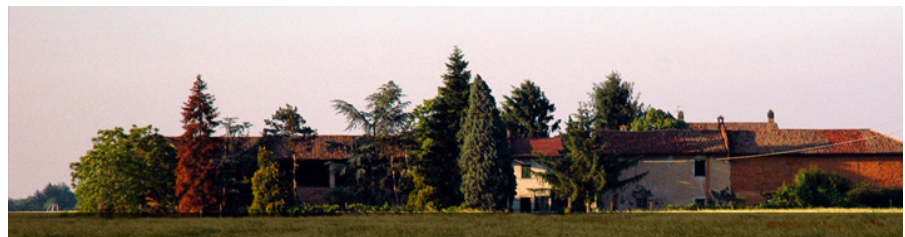
Fig. 4.48, Edificio in terra in Piemonte. fonte: http://culture-terra-incognita.org/
