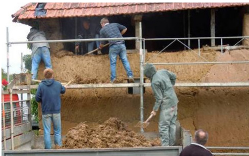
Fig. 4.21, Ricostruzione di parte di una parete in bauge nel Parco (foto da F. Streiff, "Rénovation du bâti en bauge" - Grain d'Isère 2013)
