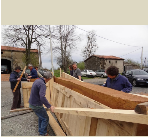
Fig. 4.10, Chantiers citoyens (foto da Johan Despres, Julianne Court, Le relance d'une filière terre en Livradois-Forez; Grain d'Isère 2013)
