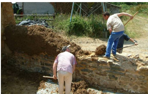
Fig. 4.15, 4.16, Preparazione dell'impasto di terra e paglia e prima fase di costruzione di un muro (foto da F. Streiff, "Rénovation du bâti en bauge" - Grain d'Isère 2013)
