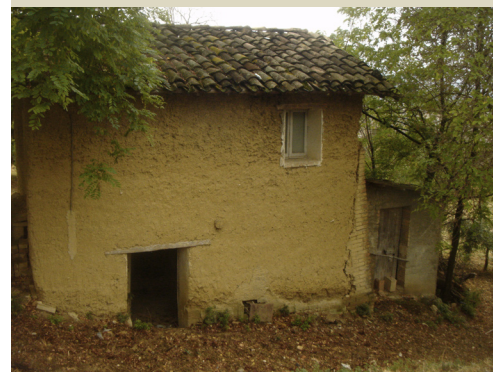
Fig. 4.23, 4.24, Abitazioni in terra cruda in provincia di Chieti, Abruzzo, realizzate con la tecnica del Massone (foto S. Parlato)
