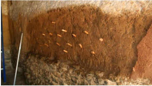
Fig. 4.20, Interventi per il reintegro di materiale alla base di un muro in Bauge nel Parco (foto da F. Streiff, "Rénovation du bâti en bauge" - Grain d'Isère 2013)
