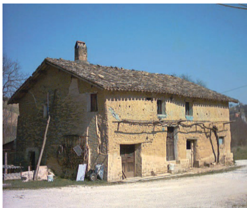
Fig. 4.33, Edificio in terra cruda nelle Marche. (fonte: Direzione Regionale per i Beni Culturali e Paesaggistici delle Marche 2005)
