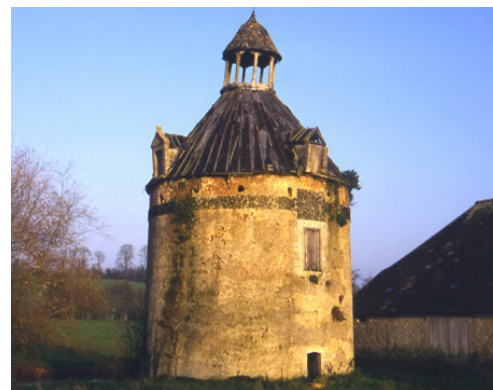
Fig. 4.11, 4.12, 4.13, Patrimonio in Bauge del XVIII° sec. nel Parco (foto F. Streiff, "Rénovation du bâti en bauge" - Grain d'Isère 2013)
