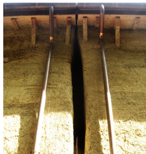
Fig. 4.28, Lavori di recupero dell'edificio di Borgocapo (2009), Casalinicontrada (CH). (foto: S. Parlato)
