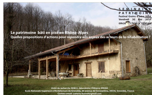
Fig. 4.52, Presso CRATerre si è tenuto nel maggio 2014 un seminario sulle strategie d'azione per il recupero del patrimonio costruito in pisé nella regione Rhône Alpes coinvolgendo tutti gli attori operanti sul territorio in materia.
