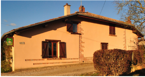
Fig. 3.4, Abitazione in terra battuta in Rhône – Alpes, Francia; le murature sono ammassate negli angoli con mattoni in cotto che con tutta probabilità riprendono l'inclinazione dei giunti dei blocchi di terra battuta nascosti dall'intonaco, che compongono il muro.
