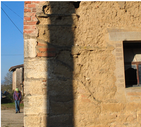
Fig. 3.5, Particolare ammorsatura d'angolo in parte in pietra in parte in mattoni cotti e calce; Valeins, Rhône – Alpes.
