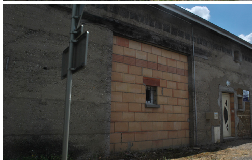
Fig. 3.8, Edifici in terra battuta nella Dombes, Rhône – Alpes; sono evidenti gli interventi inappropriati, eseguiti con elementi alieni alla tecnica costruttiva in terra. Il primo caso ha subito una sostituzione di parte della muratura in terra con blocchi in calcestruzzo alleggerito; nel secondo caso l'edificio è stato interamente rivestito con intonaco a base di cemento.
