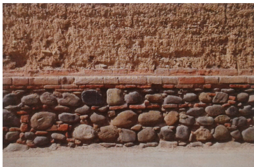
Fig. 3.14, Basamento in pietre, con corsi di mattoni cotti per facilitare la posa della parete in terra battuta, sfruttandone la superficie regolare. (foto Mattone 2010, p. 54)
