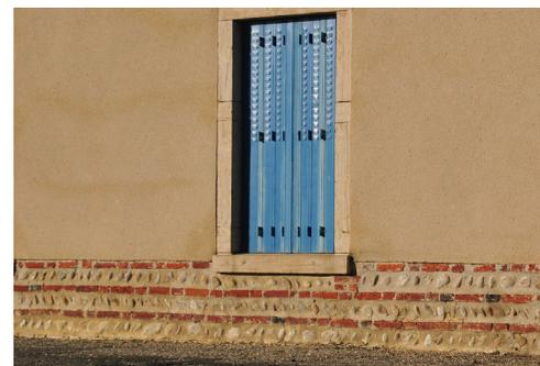
Fig. 6.5, Tipico zoccolo in ciottoli posati in opera a spina di pesce, alternati a file di mattoni cotti.
