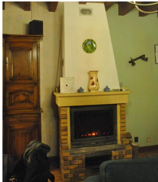
*Il Camino a focolare chiuso con visibili le bocchette del sistema di canalizzazione dell'aria calda*
