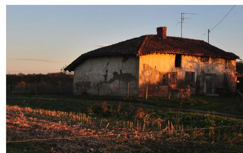
Fig. 6.3, 6.4, Edifici in pisé localizzati nella Communauté de communes Chalaronne-Centre durante sopralluoghi per la geo-referenziazione.
