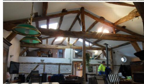
Fig. 6.6, 6.7, 6.8, Tipologie di abitazioni in pisé nel dipartimento de l'Ain, con strutture di copertura lignee (Foto 6.6, R. Pennacchio, Foto 6.7, 6.8, Buzo - Cho)
