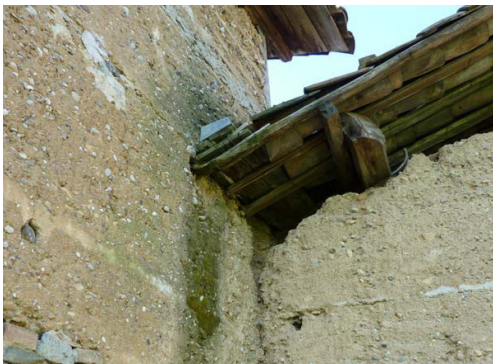
Fig. 5.13, Isère, pendenze delle coperture mal progettate portano l'acqua piovana contro una parete in terra (foto S.Moriset CRAterre, 2012)
