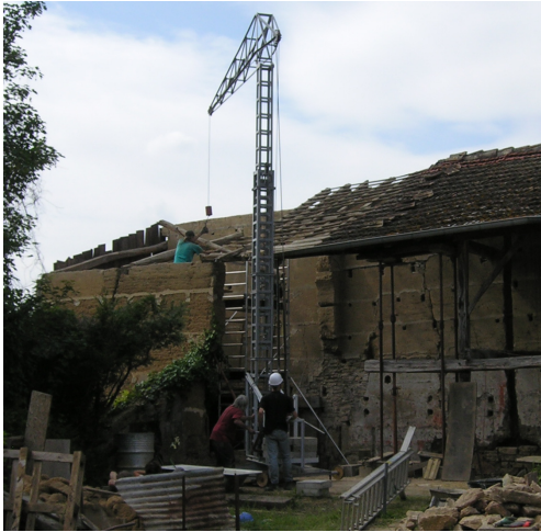
Fig. 5.27, Operazioni di smontaggio della porzione di copertura particolarmente ammalorata e a rischio di crollo, nella zona ovest dell'edificio.
