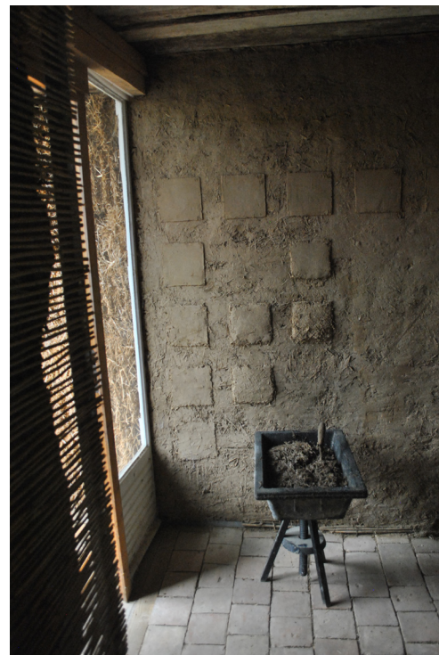
Fig. 5.16, Esperimenti per intonaci a base di terra e fibre su pannello di incannucciato, posato su parete in balle di paglia.
