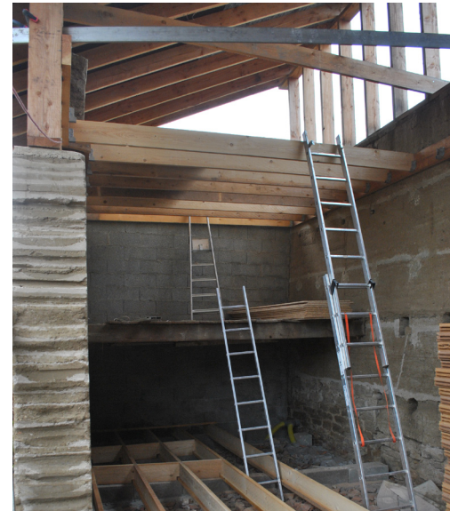
Fig. 5.21, Nuovo solaio in legno realizzato. Il vecchio solaio nella foto ancora in opera verrà in seguito smontato.
