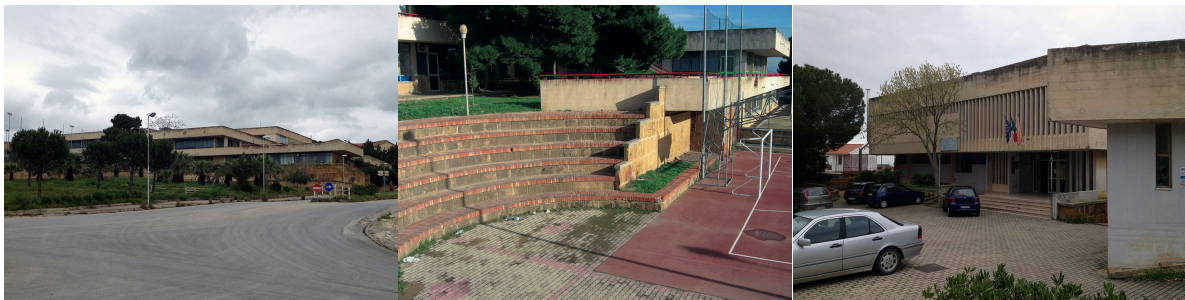
Figura 1 | Agrigento: immagini della scuola elementare nel quartiere ERP di Villasetta. Fonte: foto degli autori.
