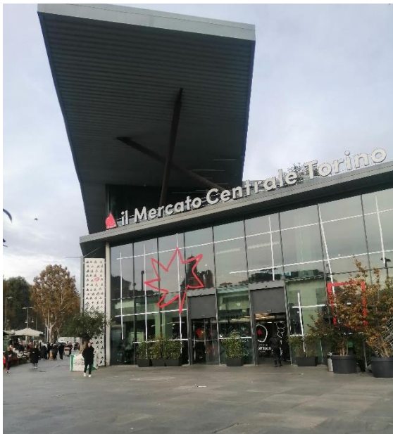
Figura 2. Il PalaFuksas, dove dal 2019 si trova il Mercato Centrale.
