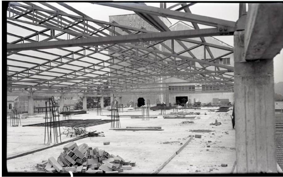
Fig. 2. Ampliamento dello stabilimento nel 1960; cantiere durante l'intervento di copertura e di collegamento con il corpo preesistente; sono evidenti le rotture in facciata della torre di testata per la continuità di percorso orizzontale fra i due corpi di fabbrica (Archivio Minoli).
