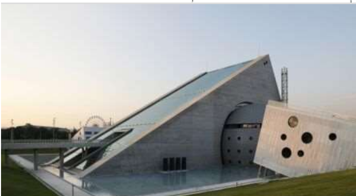
CSO ADA Ankara Konser Salonu di Uygur Architects (© Francesca Pompei)
