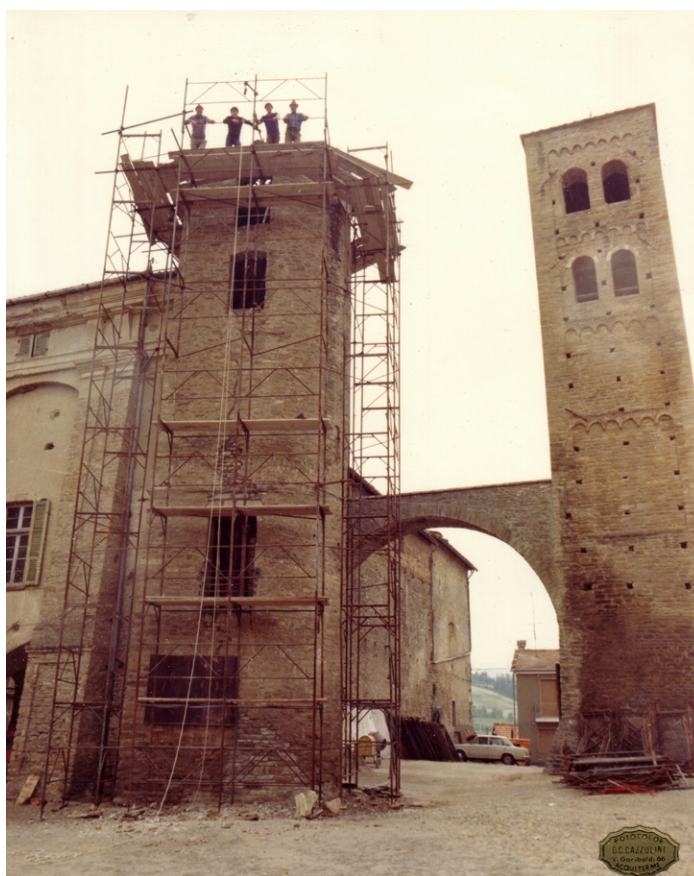
Fig. 2. Monastero Bormida, castello, torre nord cosiddetta 'semicircolare', cantiere di restauro, fotografia fine anni Sessanta del XX secolo (Biblioteca Comunale di Monastero Bormida, dossier di immagini, Restauro Torre - impresa Armando Guglieri , cod. GR2, p. 32).
