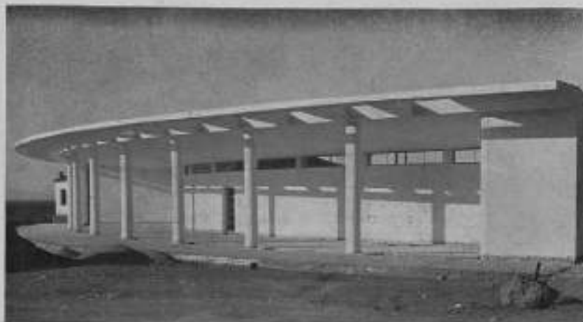
FAÇADE SUD, CAISSONS DE L'AUTENT ENLEVÉS
