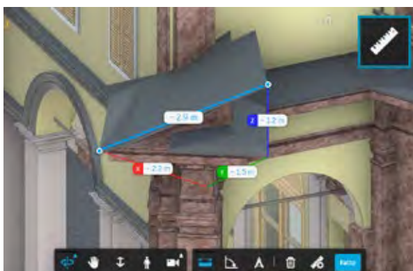
Figura 8 Misurazione nello spazio del portale in prossimità della Cappella 20 del Sacro Monte di Varallo.
