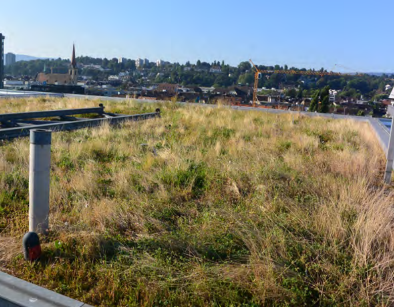
Figura 2 Tetti verdi estensivi contribuiscono ad isolare termicamente l'edificio oltre a essere habitat per flora e fauna
