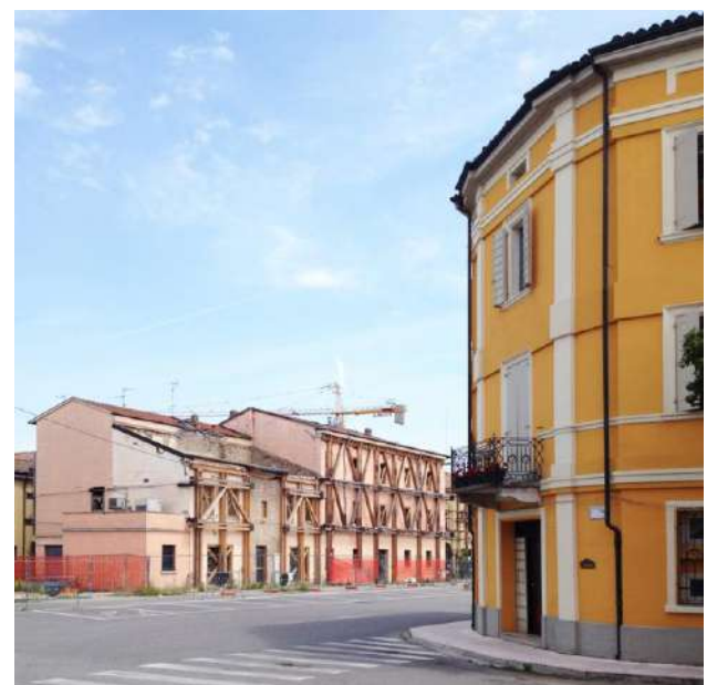
Fig. 20: demolitions in Piazza I Maggio in Novi di Modena (MO)
