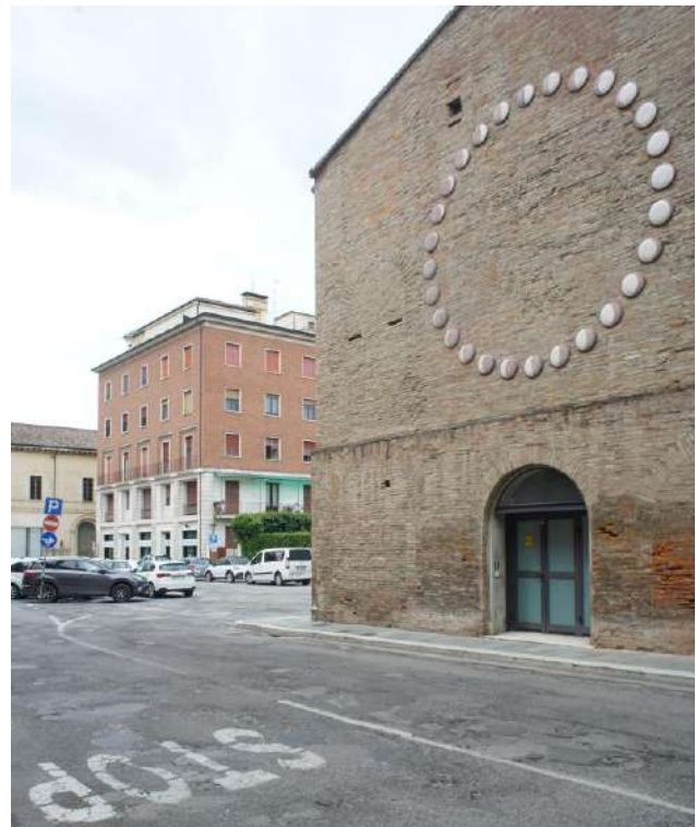
Fig. 16: ceramic installations in Piazza 2 Giugno in Faenza (RA)
