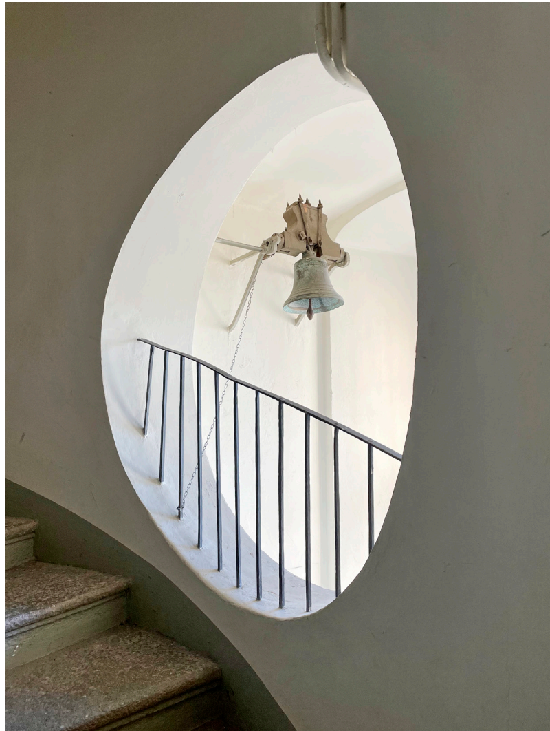
Fig. 12. Grande occhio circolare nella scala juvarriana di Superga, aperto verso l'intercapedine luminosa. L'arco rovescio ha funzione di sostegno degli scalini a sbalzo [fotografia dell'autore].
