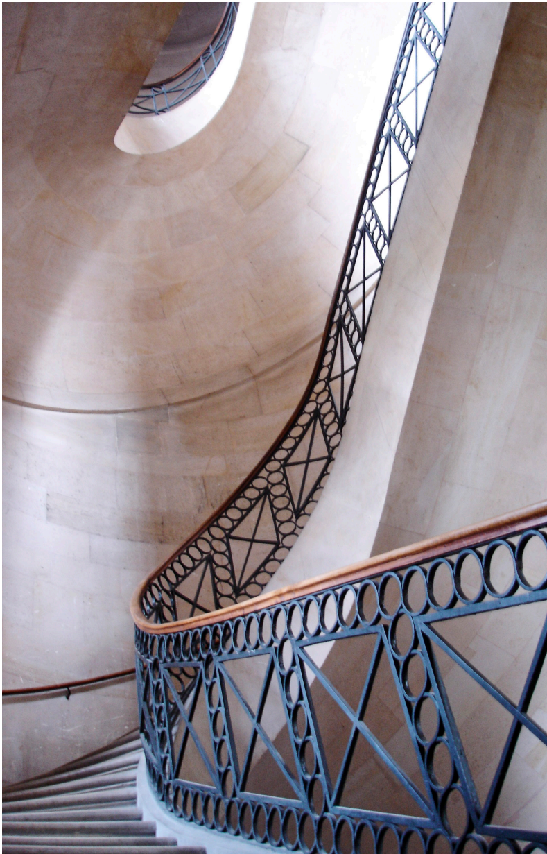
Fig. 6. Parigi, Observatoire, scorcio delle scale in stereotomia (XVII sec.) [fotografia Jean Valéro / CC BY-SA].
