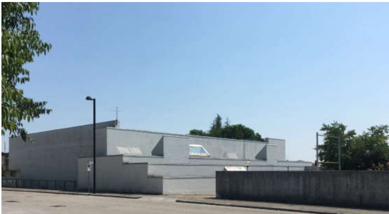
Fig. 6 Chiesa e opere parrocchiali di Vajont. Vista generale dalla via pubblica lato nord.
