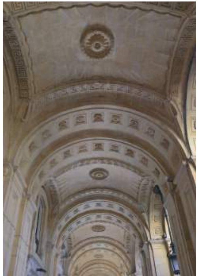
Fig. 5. La Valletta, Biblioteca, le volte sopra il portico.
