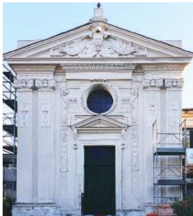
Fig. 2. Roma, Santa Maria del Priorato, facciata (2019) (Archivio SSABAP Roma).
