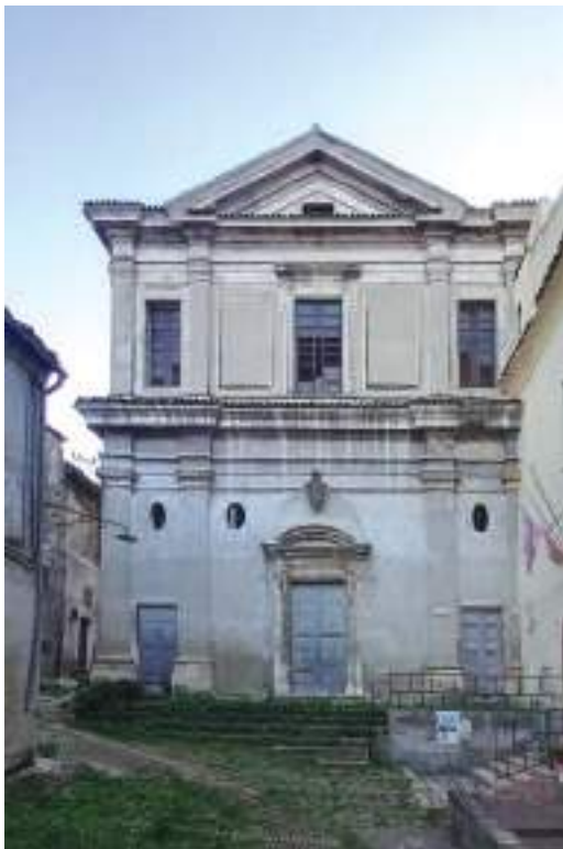
Fig. 11. Facciata principale della chiesa.
