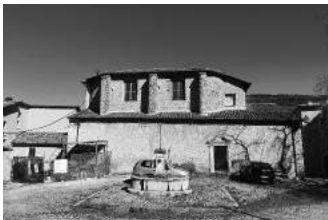
Fig. 12. Campana, chiesa di S. Giovanni, foto stato attuale del prospetto ovest.
