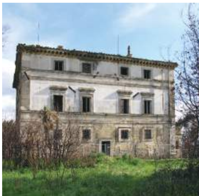
Fig. 11. Terni, prospetto posteriore di villa Palma, stato di fatto al 2013 (foto di G. Castellini Rinaldi).
