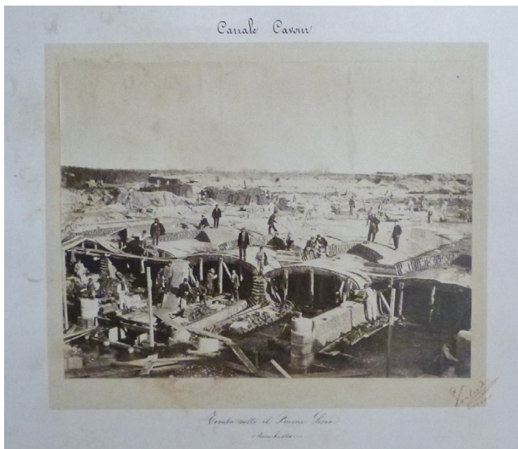
3: Tomba sotto il Fiume Sesia [Archivio Storico delle Acque e delle Terre Irrigue].
