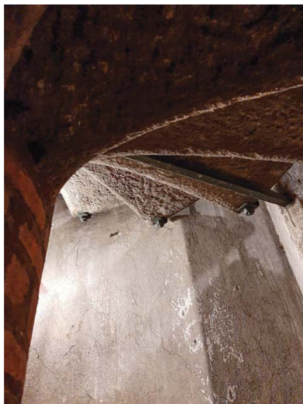
Fig. 2. Le scale elicoidali della Mole nel rilievo di Franco Rosso, a sinistra [Rosso, 1977]; i quadrelli sottoposti ai gradini che svolgono la funzione di ancoraggi alle strutture di perimetro del vano di risalita, a destra (gli ancoraggi sono evidenziati nel disegno di rilievo) [fotografia dell'autore].
