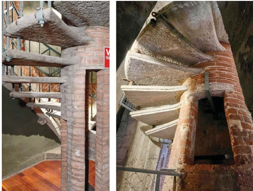
Fig. 1. Scale a sbalzo elicoidali nella Mole, a sinistra, e in San Gaudenzio, a destra [fotografie dell'autore].
