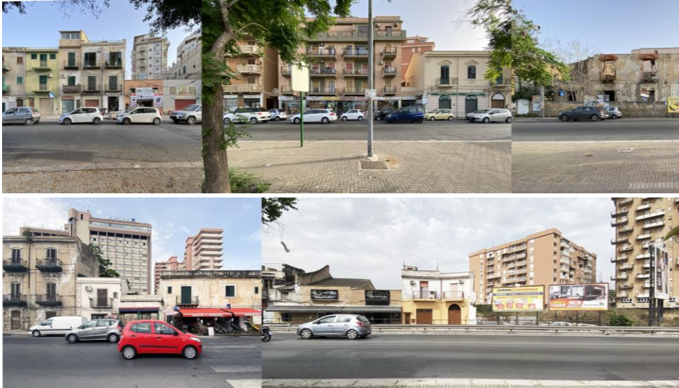
Figura 57, Figura 58: La coesistenza disordinata di edifici residenziali a basso costo, vuoti urbani, edifici dismessi, costruzioni e attività abusive lungo via Messina Marine (2021).
