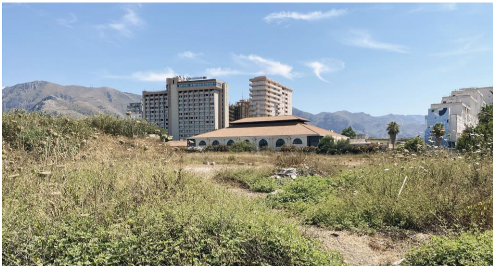
Figura 65: L'edificio e la prossimità con emergenze naturalistiche, come la foce del fiume Oreto (2021).
