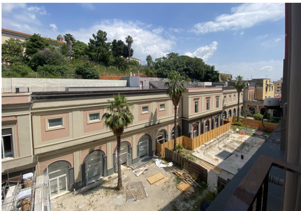
Figura 109: Il cantiere del giardino della Vannella – nuova sezione del museo più a perta alla città - e gli spazi aperti dell’istituto Colosimo che verranno in futuro collegati con il museo tramite un sistema di rampe e terrazzamenti (2021).
