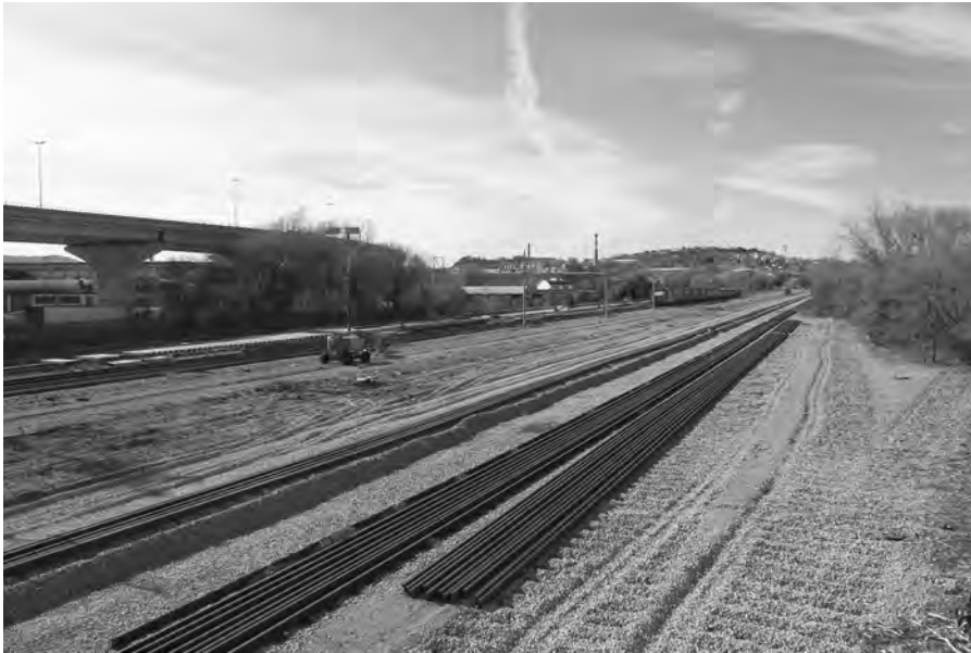
3. Dorsale ferroviaria Trieste Campo Marzio-Servola-Aquilinia in costruzione. Fotografia di Leonardo Ramondetti.
