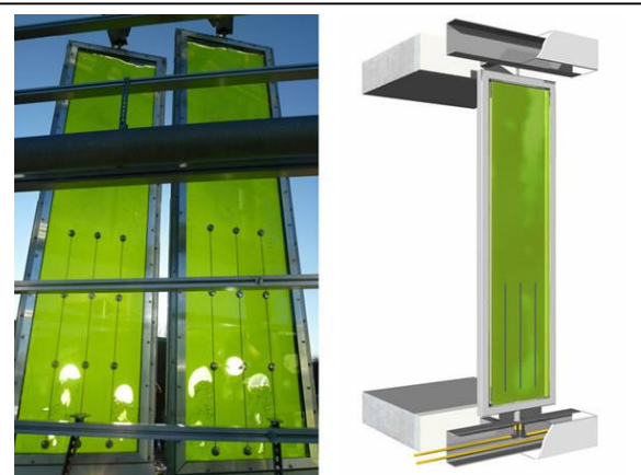
Fig. 8: Casa de algas. Ddetalle de paneles de la fachada
