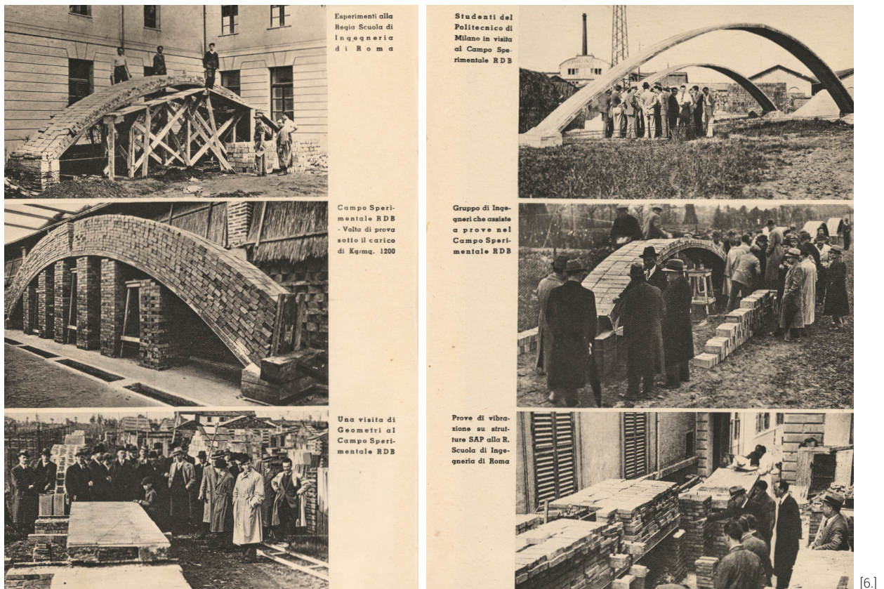
Fig. 6. Documentazione fotografica delle sperimentazioni su strutture SAP. Da: brochure pubblicitaria Volta SAP , 1939 (collezione privata dell'autore).
