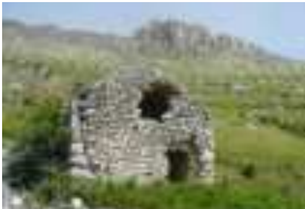
3: Gran Sasso d'Italia, Campo Imperatore (Abruzzo): un rifugio della pastorizia presso il Monte Bolza. La tecnica costruttiva delle volte a botte in pietra risale al medioevo ed è stata sostituita dall'uso di mattoni, nelle aree a valle, dal XV secolo.
