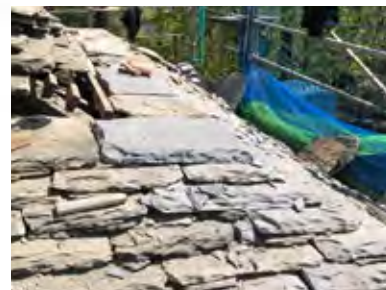
Figura 54 Espluvio angolare. Cappella di Abramo - Sacro Monte di Ghiffa. Arch. Scotton.
