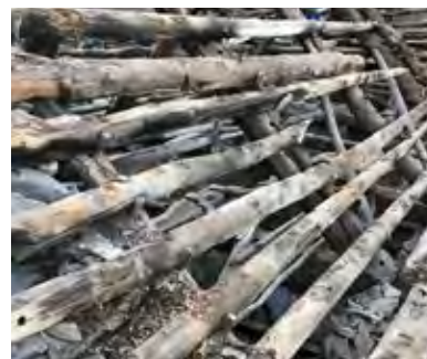
Figura 4 Vecchia carpenteria. Si nota il sistema di fissaggio delle tampiere con "chiodi" lignei e la prosecuzione delle stesse sul muro del frontone.
