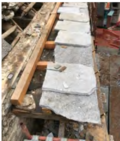
Figura 17 Gronda con mensola sottoposta. Partenza posa piode. Veglio - Montecrestese (VB). Arch. Scotton
