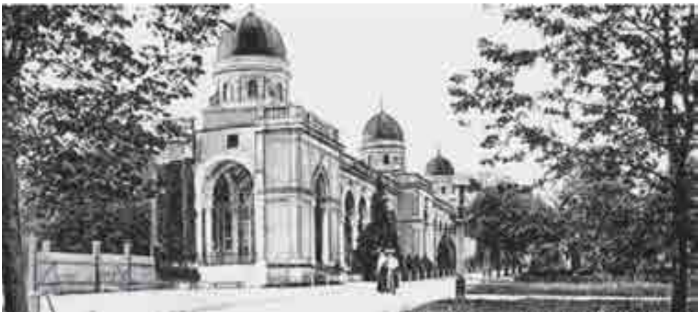
1: Zagabria, il Complesso Monumentale di Mirogoj all'inizio del XX secolo [Fonte archivistica della sede del Cimitero Comunale].
