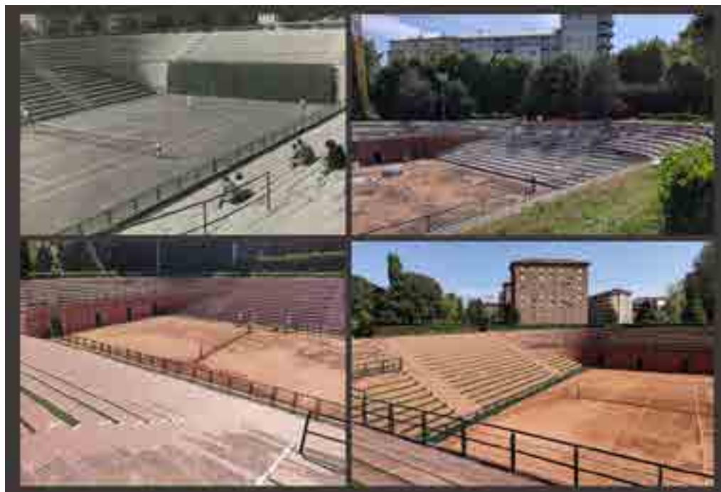
5: Lo stadio del tennis così come ripreso in uno scatto d'archivio (fondo Domenico Morelli) a costruzione appena ultimata, in una fase dell'ultimo cantiere, e infine nello stato di fatto (foto dell'autore).
