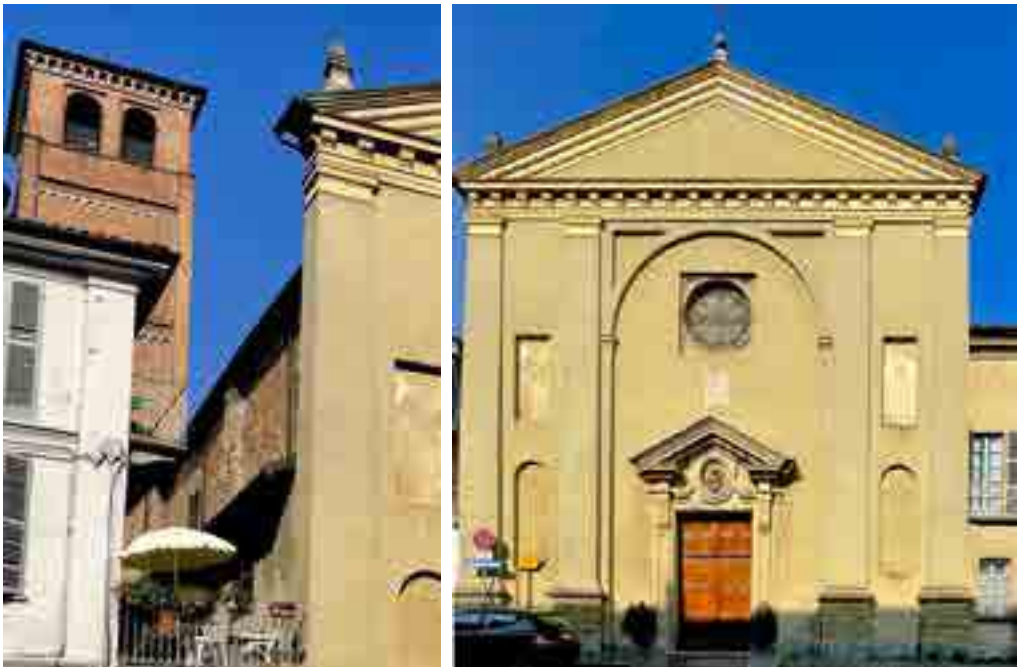
2-3: Santa Maria Nuova, Asti, dettaglio torre campanaria, fianco nord e facciata principale della chiesa (oggi convertita al culto ortodosso) [foto I. Papa, luglio 2022].
