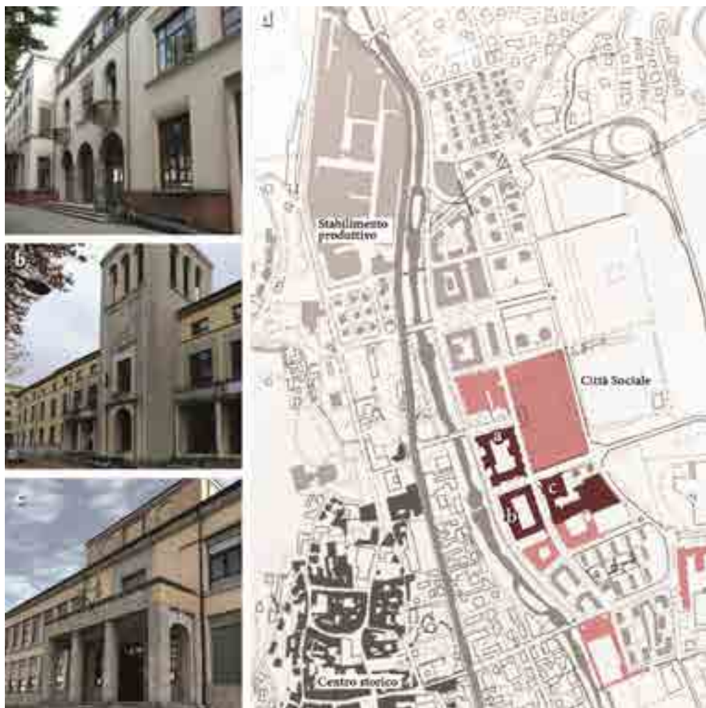
T: a: Scuola dell'infanzia "V.E. Marzotto" e della prima infanzia "L'albero delle Meraviglie"; b: I.C. "Valdagno 2" (scuola primaria e secondaria di primo grado); c: Istituto Tecnico IIS "Marzotto-Luzzatti"; d: planimetria di Valdagno. In rosa le strutture ricreative e educative della Città Sociale. In rosso i tre edifici oggetto di studio. ©Danesi, Peron.
