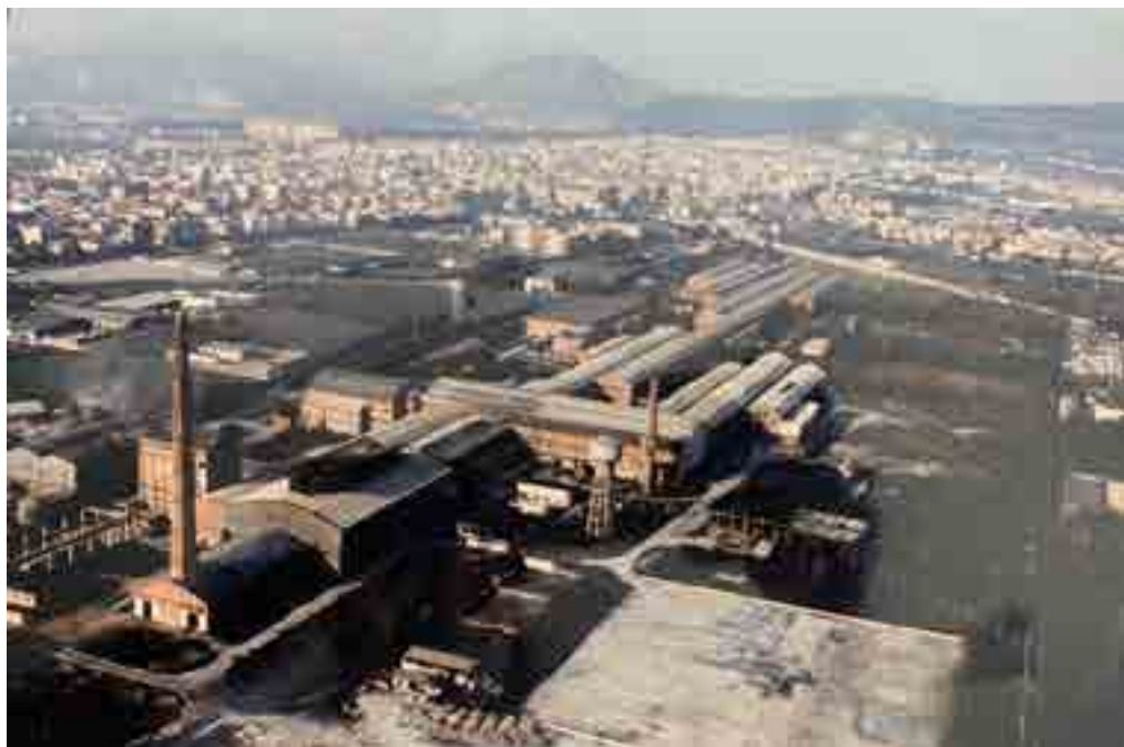
2: Lo stabilimento negli anni successivi alla sua chiusura. Sullo sfondo si estende la città di Caserta; in alto a sinistra è visibile il monumentale Palazzo Borbonico (fonte: AUC).
