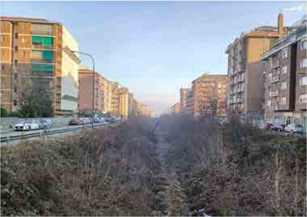
3: Oddi R. F., Veduta della trincea ferroviaria dismessa tra via Gottardo e via Sempione, Torino, 2022 [Fonte: foto Roberta Francesca Oddi 27/01/2022].
