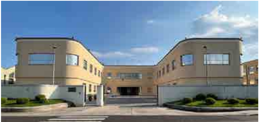
4: Pontedera, Palazzina direzionale (foto dell'autore).
