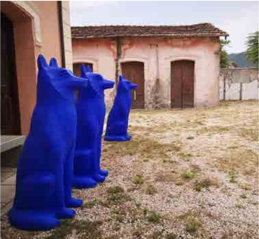
5: Vista esterna dell'ex Mattatoio di Avezzano, oggi nuova sede dell'Aia dei Musei animato dai lupi del Collettivo Cracking Art. Si noti lo stato di abbandono e degrado in cui versano alcuni dei manufatti architettonici dell'antico opificio. (C. Verazzo 2021)
