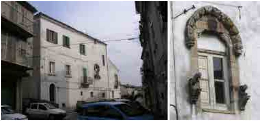
3: Dettaglio di palazzo De Marco, con vista sul fronte principale in corrispondenza di via Salita Castello, con dettaglio della finestra in stile gotico-pugliese ad arco acuto, con cornice decoramentale.
