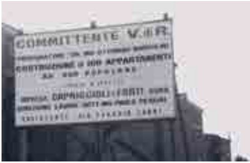
7: Il cartello di cantiere del villaggio di Acilia, Marcolini compare come procuratore.
