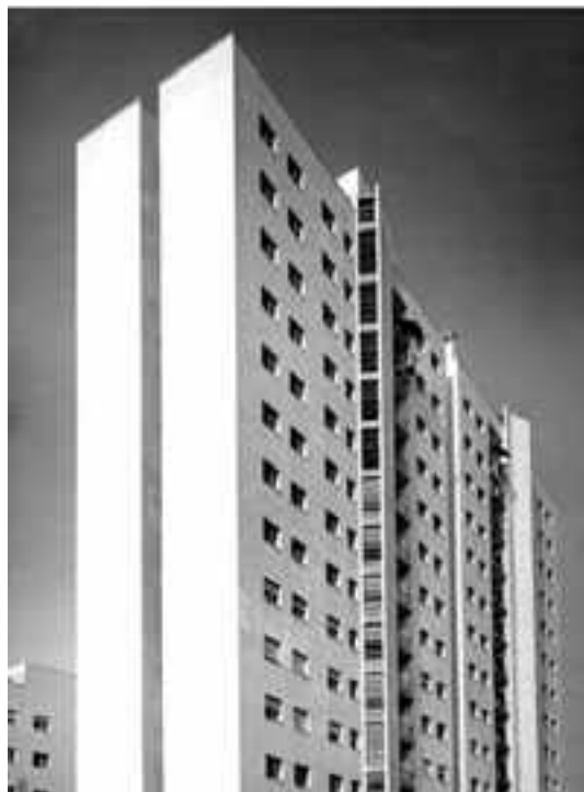
3: L. Moretti, Case-albergo, via Corridoni, Milano, 1950, veduta della facciata del corpo alto (Archivio Moretti Magnifico, Roma).
