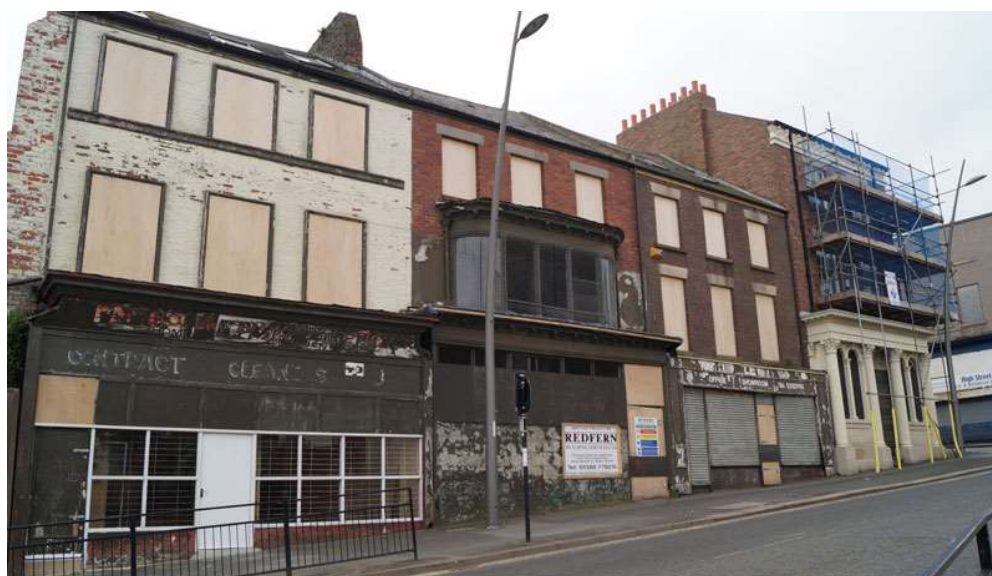
Fig. 6.31. High Street, Sunderland (UK): stato di fatto prima dell'intervento ( https://openheritage.eu/heritage-labs/high-street-sunderland/ )
