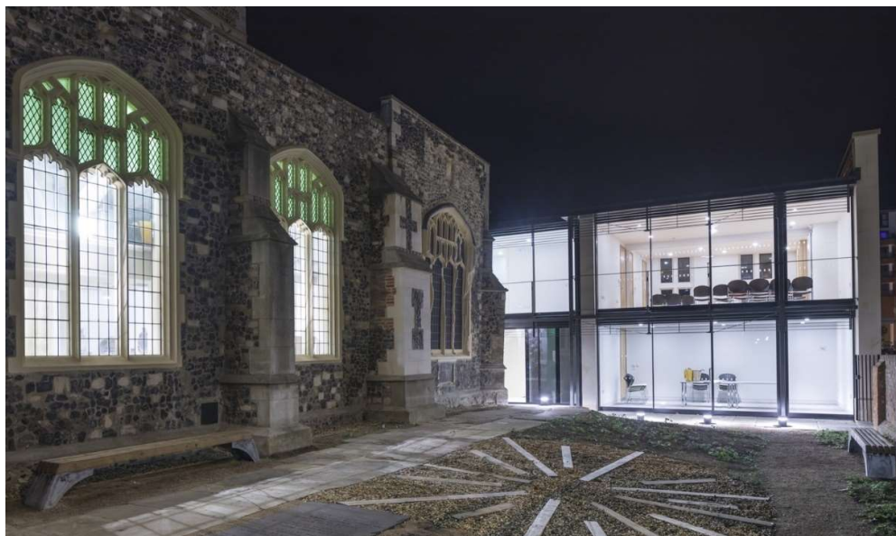
Fig. 6.7. Church of St Mary-at-the-Quay, Ipswich (UK): intervento di restauro e rifunzionalizzazione in centro per la comunità e il benessere promosso dal Churches Conservation Trust ( https://www.archdaily.com/798740/st-mary-at-the-quay-molyneux-kerr-architects )
