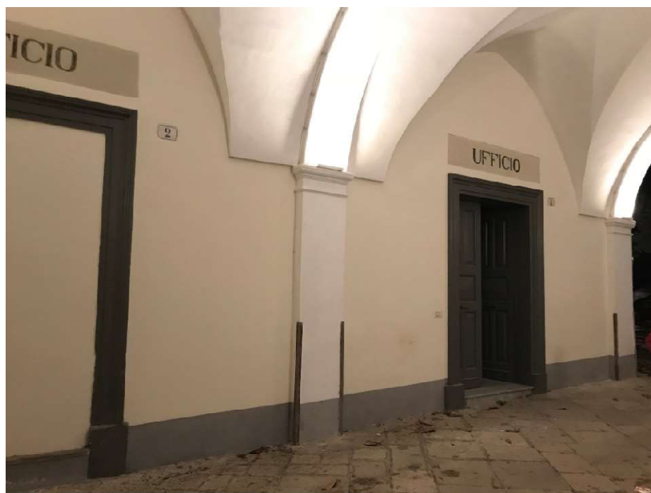
Figg. 5.47-5.48. Distilleria De Giorgi: stato di fatto prima e dopo l'intervento di restauro terzo lotto (foto L. Sambati, 2016-2018)
