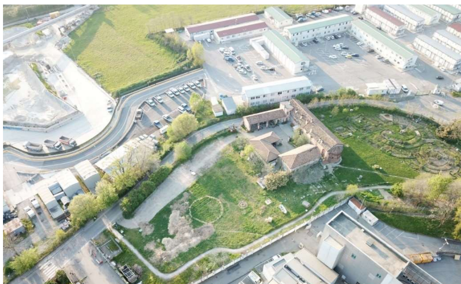
Fig. 5.33. Cascina Sant'Ambrogio: vista aerea del complesso ( https://CasciNet.it/ )
