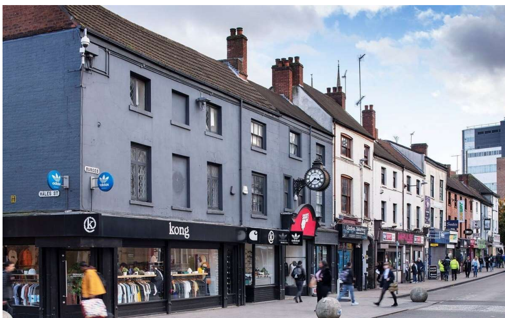
Fig. 6.3. Burges, Coventry (UK): stato di fatto prima dell'intervento di rigenerazione finanziato dal Heritage Action Zone Programme ( https://historicengland.org.uk/services-skills/heritage-action-zones/regenerating-historic-high-streets/ )
