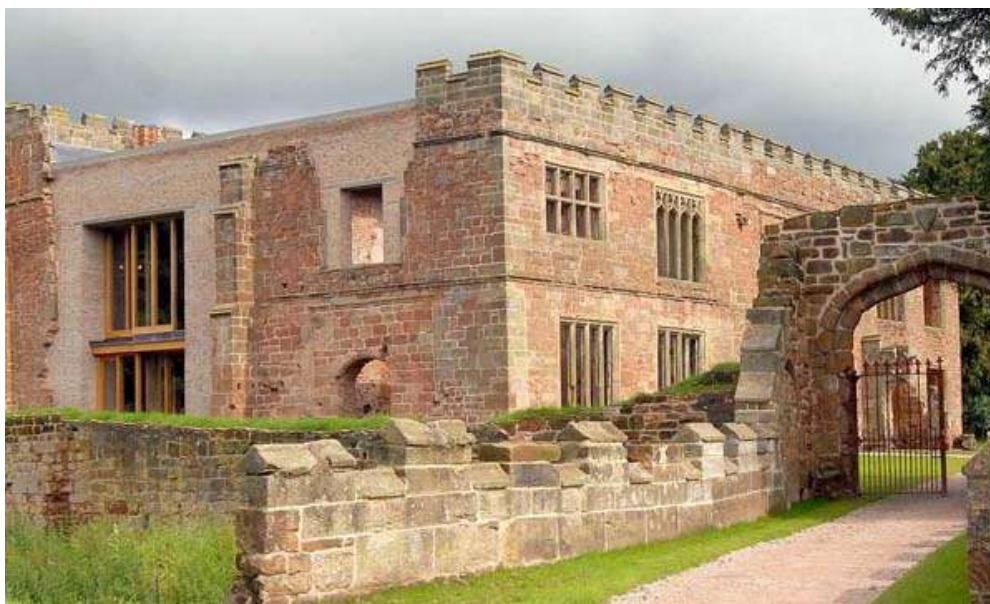
Fig. 6.5. Astley Castle (UK): intervento di restauro e rifunzionalizzazione in casa vacanze promosso dal Landmark Trust ( https://www.landmarktrust.org.uk/search-and-book/properties/astley-castle-4806/#Overview )
