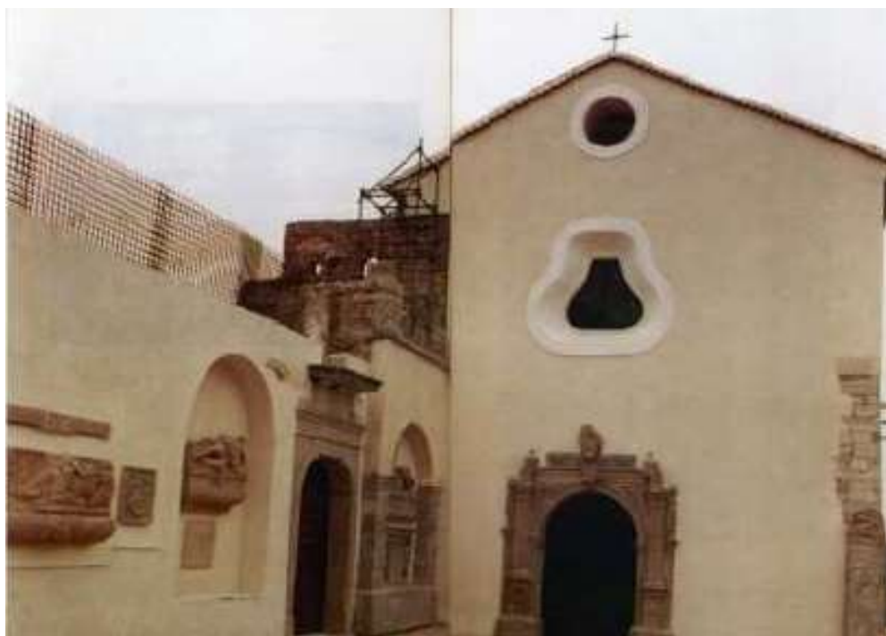
Fig. 5.27. Convento di San Marco: stato di fatto durante la ricostruzione post-sisma (Chiusano, s.d.)
