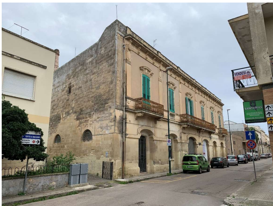
Fig. 5.43. Distilleria De Giorgi: fronte su via pubblica (foto D. Dabbene, 2021)
