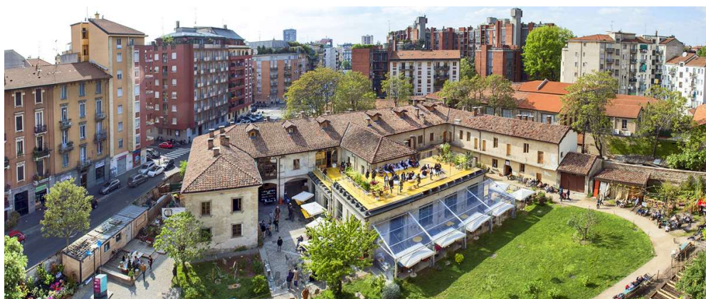
Figg. 2.16-2.17. Cascina Cuccagna Milano: restauro cascina storica e trasformazione in centro di cultura e partecipazione, stato di fatto prima e dopo l'intervento (progetto Marco Dezzi Bardeschi, 2006) ( https://www.cuccagna.org/chi-siamo/ )
