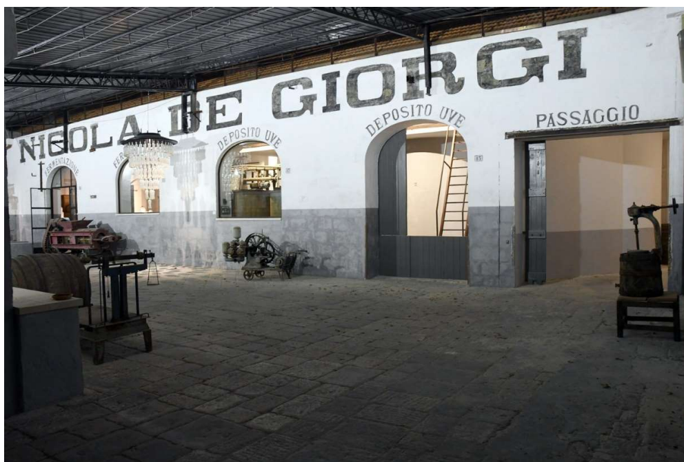
Fig. 5.44. Distilleria De Giorgi: vista d'insieme del reparto Filtri pressa che dà accesso alla sala Fermentazione-deposito uve (foto A. Monte, 2017)
