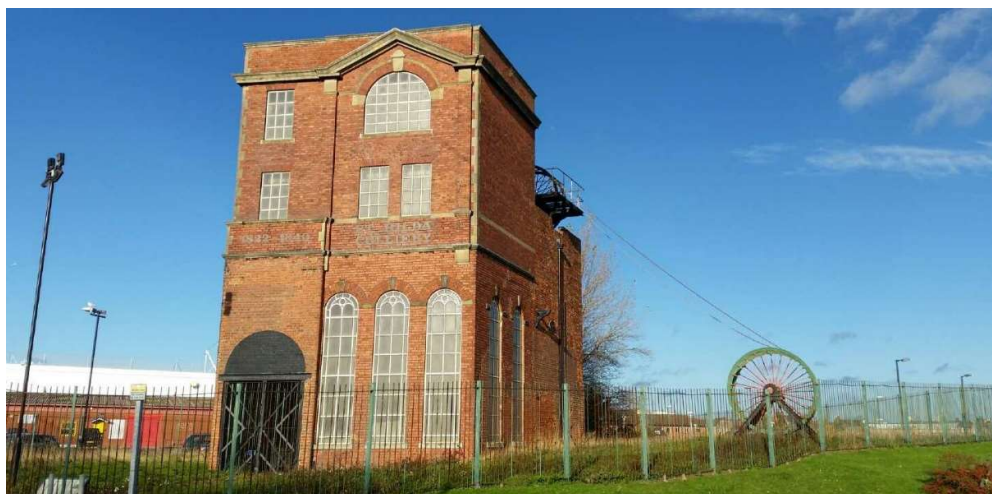
Fig. 6.9. Miniera di St Hilda, South Shields (UK): intervento di restauro e rifunzionalizzazione in centro per la comunità promosso dal Tyne and Wear Building Preservation Trust ( https://oldlowlight.co.uk/ )
