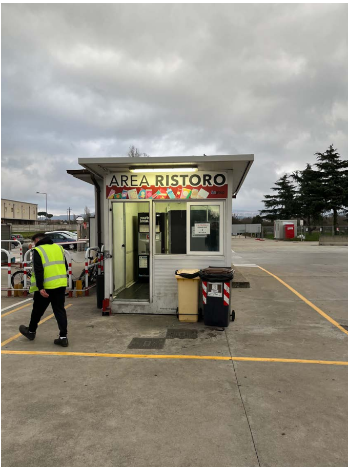
fig. 3. Centro distributivo a Santa Palomba (Roma), area ristoro. Foto dell'autore.
