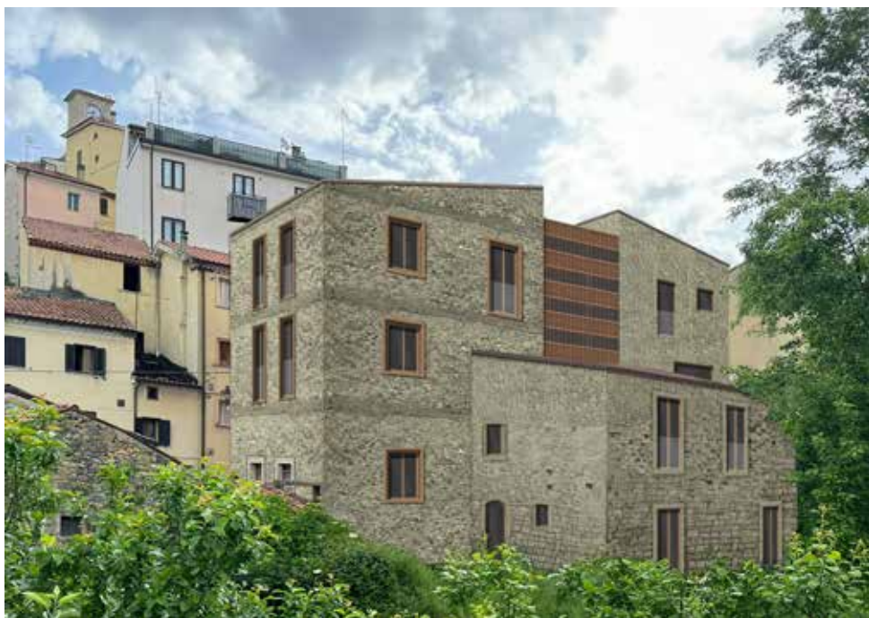
Fotografia 6. Cohousing sociale, Castel del Giudice, Alto Molise R. Levrieri, A. De Rossi, L. Servillo, L. Mascino, F. Serra, M. Tempestini (in costruzione)
