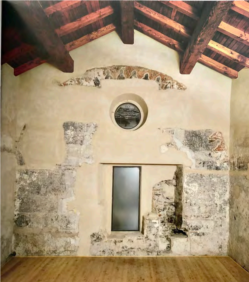
Fig. 6. Vista interna della Camera stellata, durante le opere di restauro pittorico (in CERRI 2004, p. 145).
