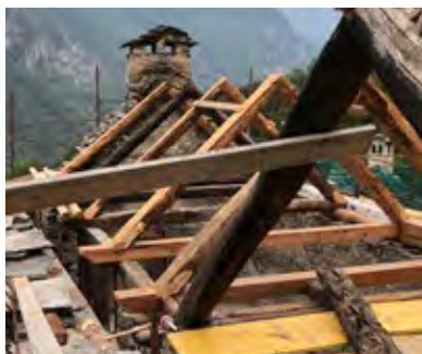
Figura 2 Carpenteria di tetto tipico ossolano. Si evidenzia l'assenza di trave di colmo. Veglio - Montecrestese (VB). Arch. Scotton
