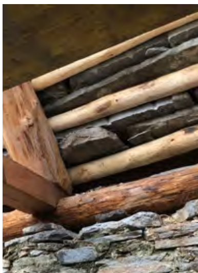
Figura 24 Manto triplo corso. Veglio - Montecrestese (VB). Arch. Scotton
