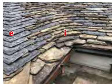
Figura 47 Manto con impluvio (i) tondo ed espluvio (e) angolare. Cappella di Abramo - Sacro Monte di Ghiffa. Arch. Scotton.
