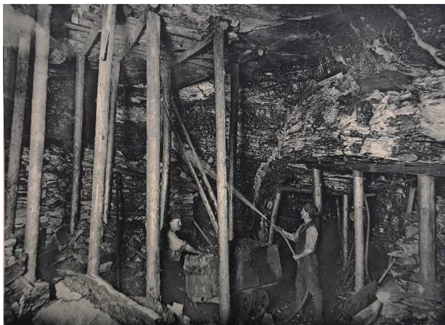
Bagnatura della polvere di carbone per limitare le polveri sottili, ASPoliTo, Archivio Storico del Politecnico di Torino.
