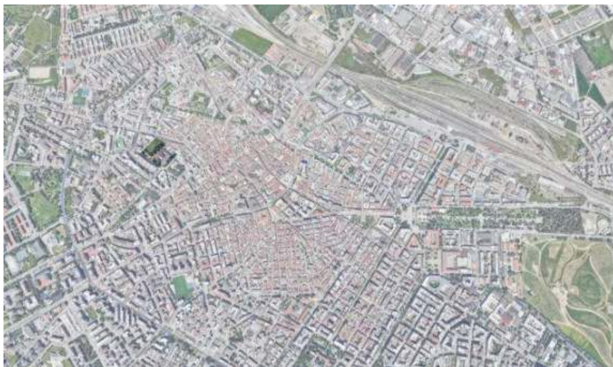
Fig. 1. Inquadramento dell'Ex-Distretto Militare nella maglia urbana di Foggia (vista aerea da Google Earth).
