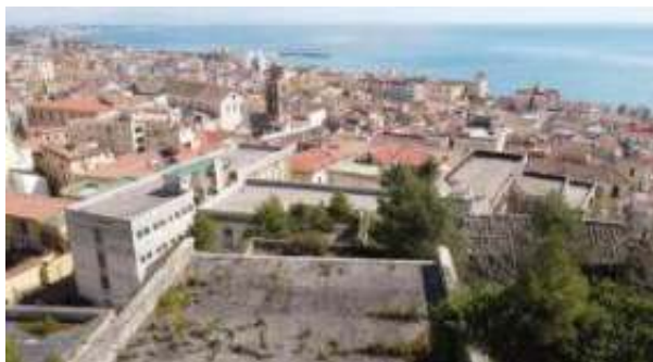
Fig. 3. Vista del complesso allo stato attuale di rinaturalizzazione e abbandono (foto dell'autore).
