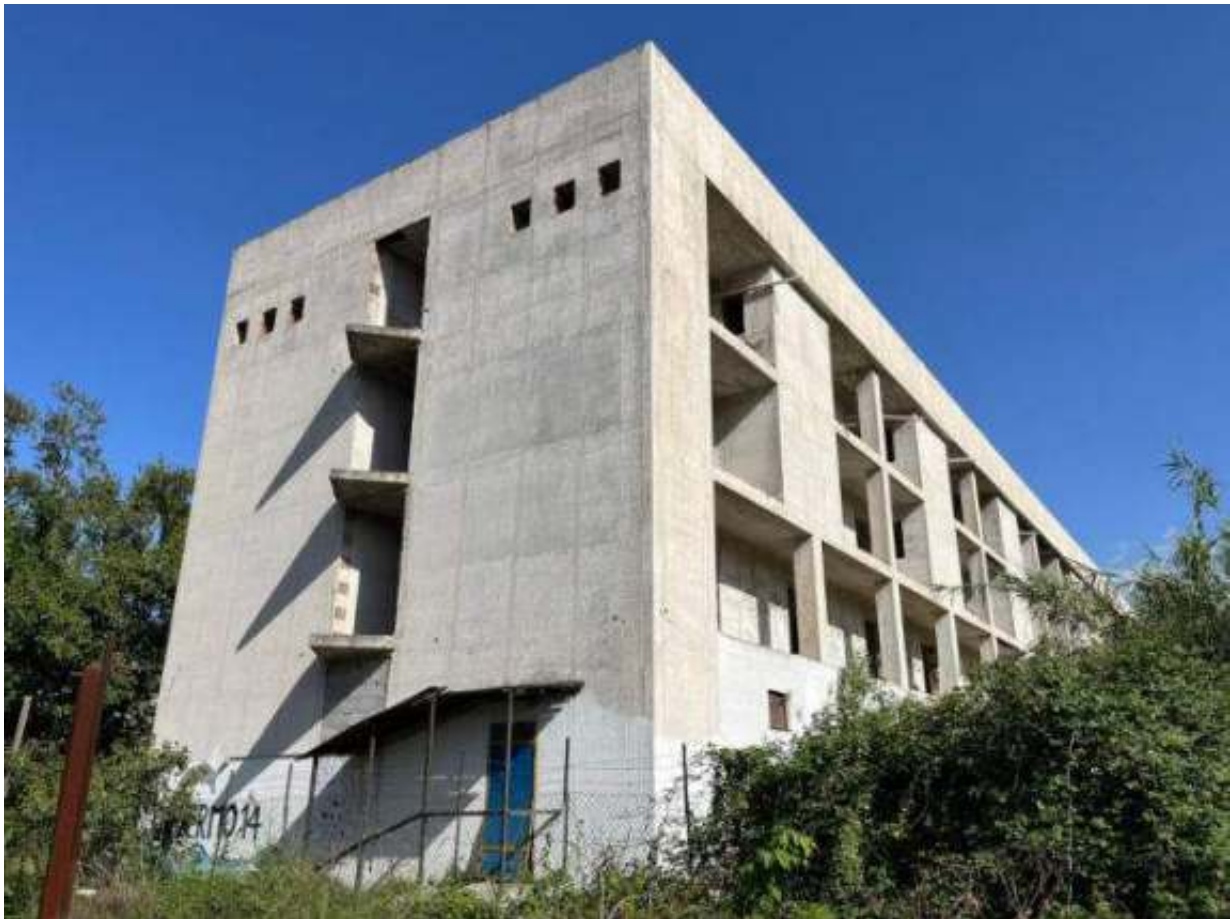
Fig. 2. Palermo, edificio incompiuto di Via Pietratagliata Santa Margherita, angolo nord-nord-ovest dell'edificio (foto dell'autore).
