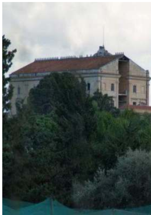
Fig. 4. Casena Grande, il fianco dell'edificio ripreso dal fondo San Gabriele tra Pallavicino e lo ZEN (foto dell'autore).
