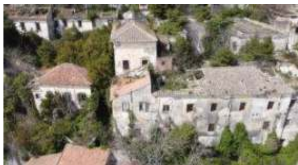
Fig. 4. Vista del complesso allo stato attuale di rinaturalizzazione e abbandono (foto dell'autore).
