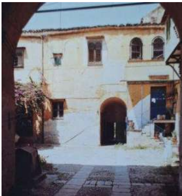
Fig. 4 Villa Maltese, cortile interno agli inizi degli anni '90 (foto per gentile concessione di G. Sommariva).
