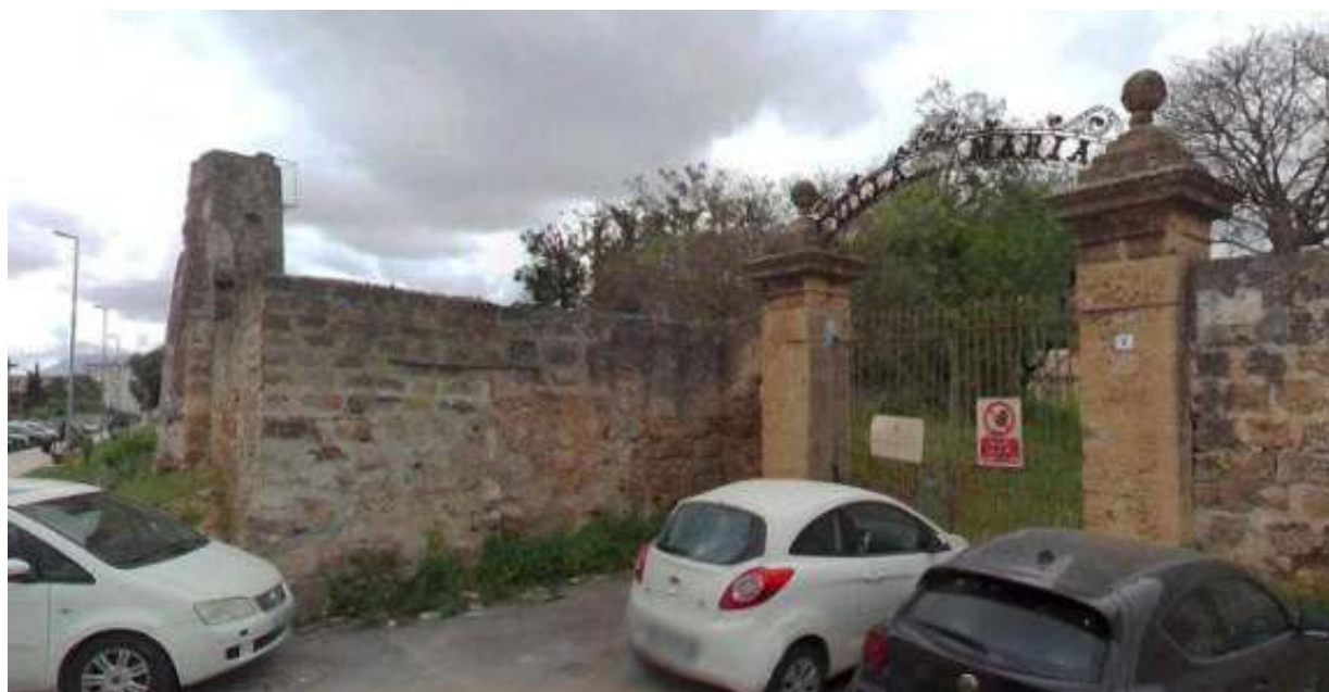
Fig. 3. Villa Maltese, piloni di ingresso ottocenteschi, in asse con l'odierna Via Maltese (immagine da Google Earth).
