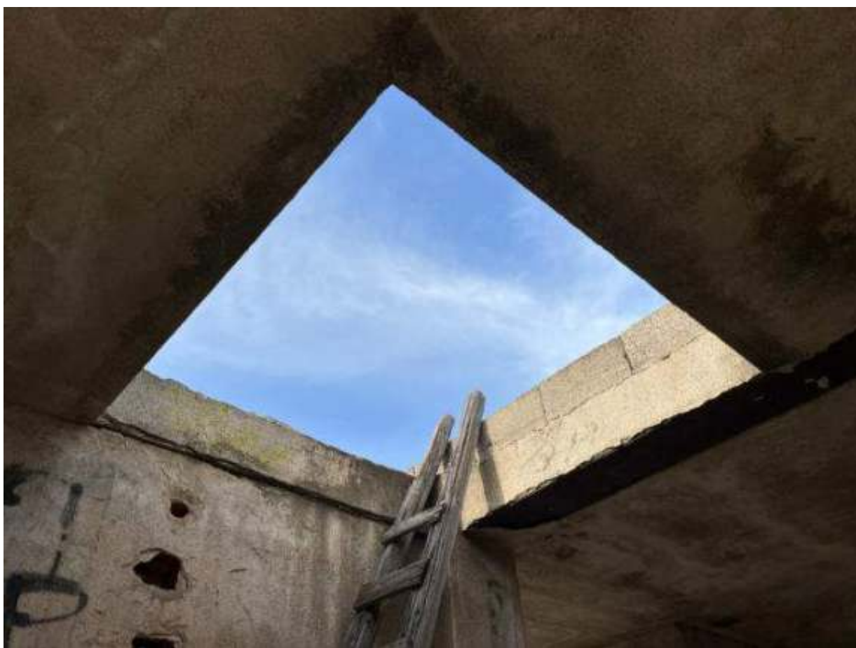
Fig. 6. Palermo, edificio incompiuto di Via Pietratagliata Santa Margherita, chiusura orizzontale superiore (foto dell'autore).
