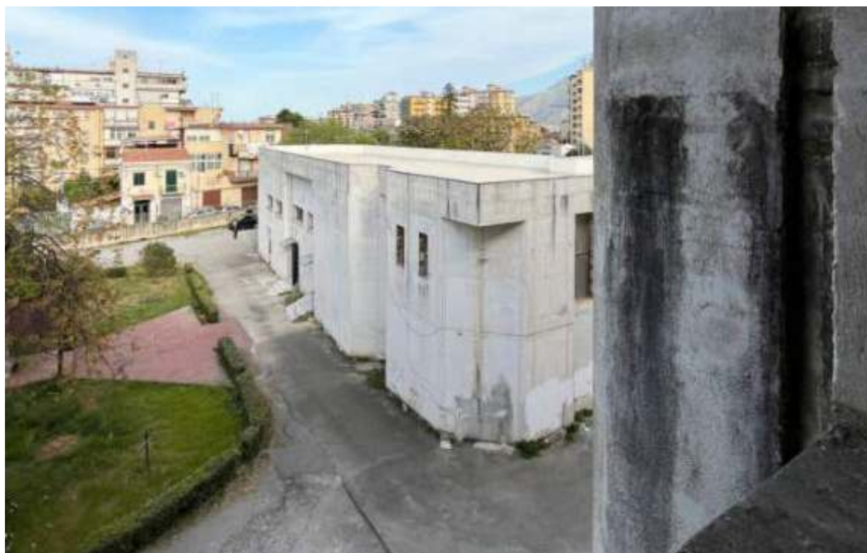
Fig. 1. Palermo, edificio incompiuto di Via Pietratagliata Santa Margherita, edificio minore visto dall'edificio maggiore (foto dell'autore).
