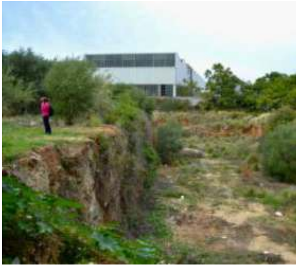
Fig. 5. Palermo, area di Villa Maltese. Vista dello scavo di fondazione ad "L" all'interno del complesso, reinterpretato come infrastruttura spaziale latente e risorsa per la creazione di nuovi spazi pubblici e dispositivi di uso collettivo, in linea con approcci di rigenerazione adattiva e temporanea (foto F. R. Bruno).
