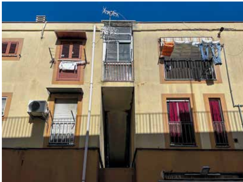
[6] Dettaglio del prospetto su Via Serino.
