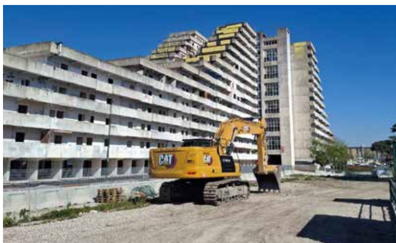
[8] Cantiere in corso con la Vela Celeste (Vela B).
