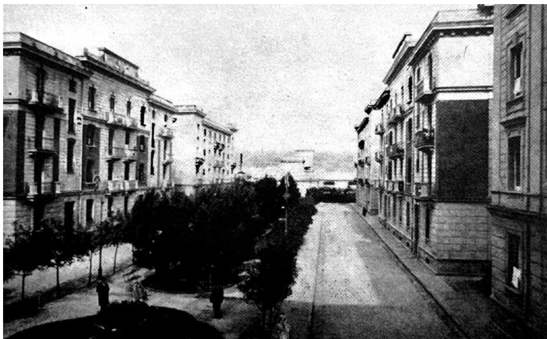
[3] In alto. Edificio del lotto a nord-est, arch. Luigi Cosenza.
