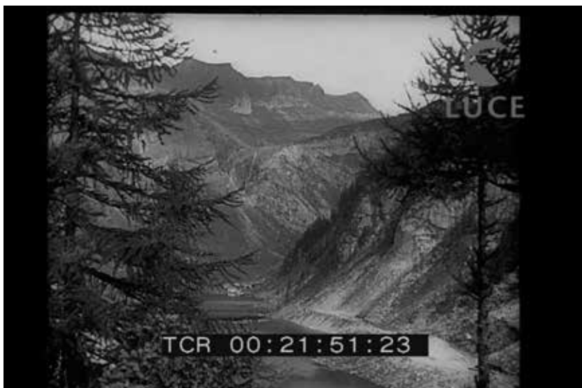
Figura 5. Fotogramma dal documentario sulla costruzione della diga di Agaro con il paese. Archivio Luce, Rif. D040402, giugno 1936.
