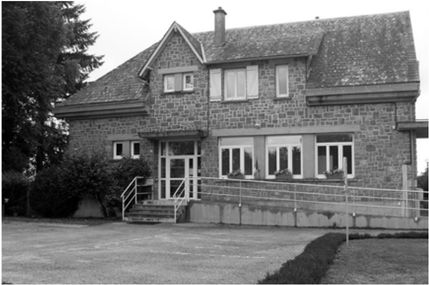
Figura 11. Confolent-Port-Dieu. Il Municipio costruito nel nuovo villaggio. Da: < https://google.com/maps >
