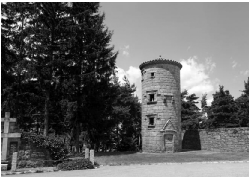
Figura 24. Naussac. La torre abbaziale che venne smontata e ricostruita in prossimità del recinto del nuovo cimitero.
