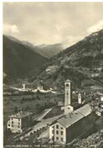
Figura 5. Casteldelfino. Ai piedi della montagna si vede l'edificio della Centrale idroelettrica e, a destra, l'edificio per alloggi, entrambi progettati dall'ing. Sacchi. Cartolina.
