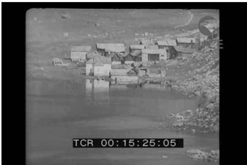
Figura 4. Fotogramma dal documentario sulla costruzione della diga di Agaro con il paese durante la sommersione. Archivio Luce, Rif. D040402, giugno 1936.
